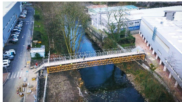
Figura 11. Fase intermedia de ejecución de la pasarela provisional
