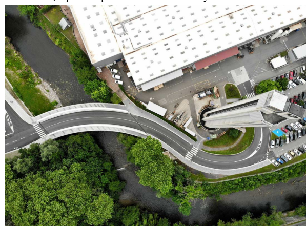
Figura 2. Vista aérea del nuevo puente terminado
