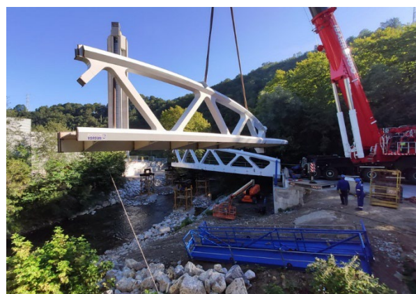
Figura 23. Proceso de colocación del segundo tramo de celosía, margen derecha lado aguas arriba
