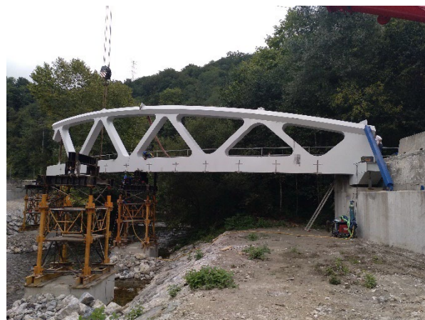
Figura 22. Primer tramo colocado y apuntalado lateralmente al estribo
