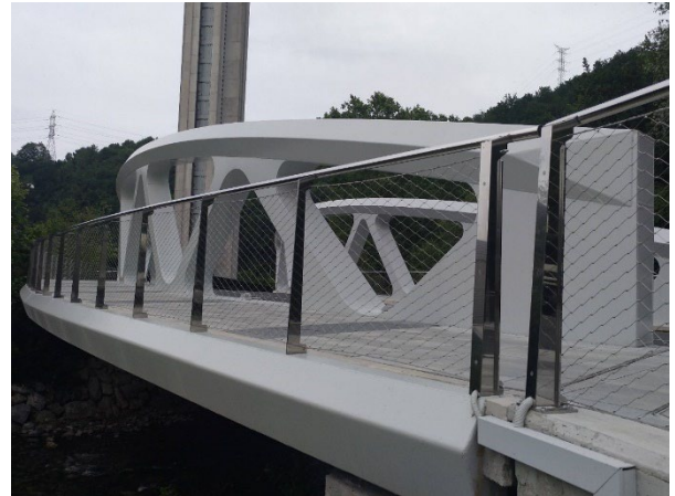
Figura 9. Barandilla en accesos y acera aguas arriba
