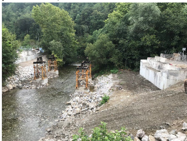
Figura 20. Torres de apeo dispuestas en el cauce, y rampa de acceso a la base de los apeos
