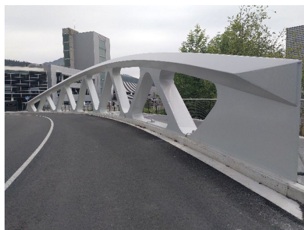
Figura 5. Detalle de zona maciza en arranque, y carenado achaflanado en cordón superior
