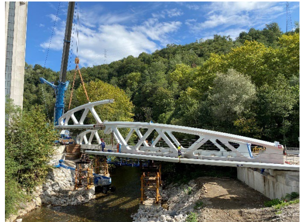
Figura 27. Montaje del cuarto y último tramos
