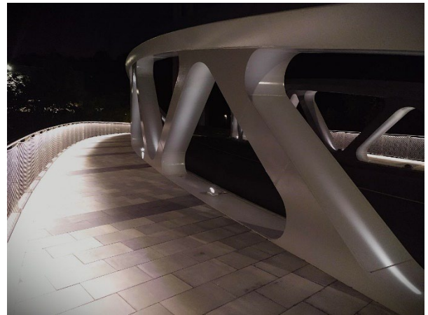
Figura 10. Iluminación de aceras alojada en pasamanos de la barandilla
