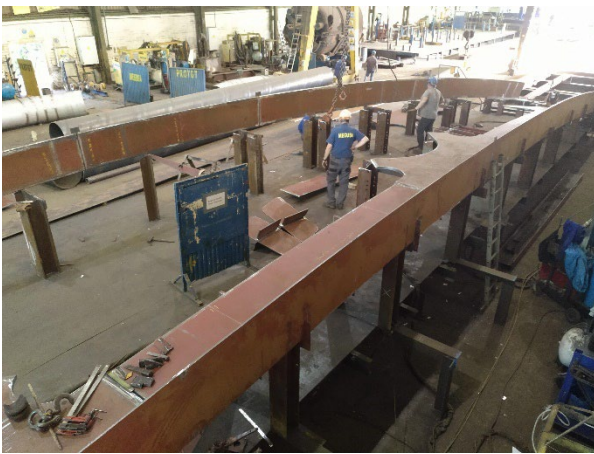
Figura 14. Proceso de ensamble en taller de una de las celosías con el lado convexo hacia arriba
