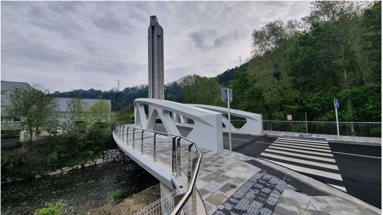
Figura 30. Puente terminado desde el acceso aguas arriba de la margen derecha
