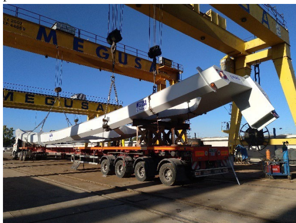
Figura 19. Transporte de primer módulo de celosía
