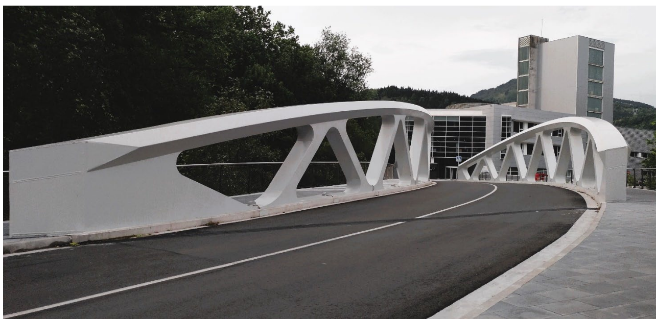
Figura 4. Vista de la obra terminada desde margen izquierda o lado Lastaola
