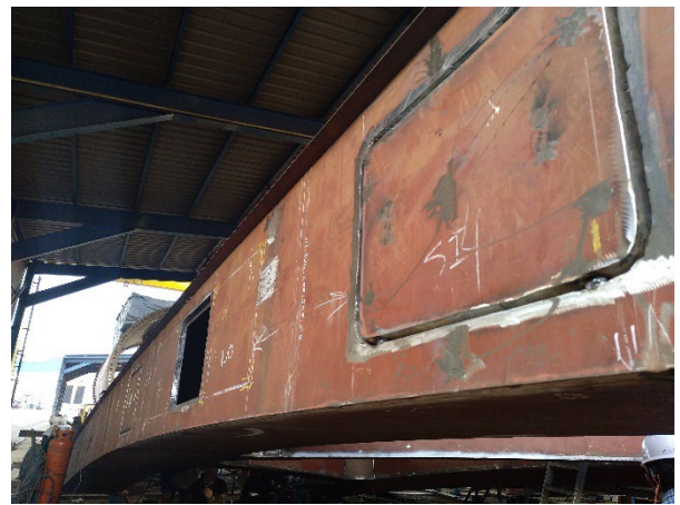
Figura 17. Ventanas en cara exterior de cordón cerradas tras finalizar la rigidización interior
