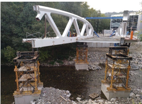
Figura 25. Primera mitad de tablero a la espera de recibir los tramos de la margen izquierda
