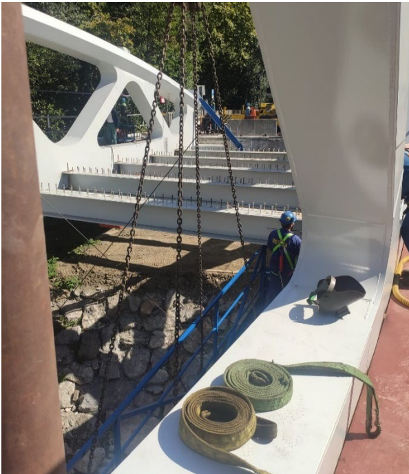
Figura 24. Montaje de vigas transversales entre cordones inferiores
