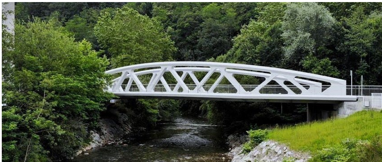
Figura 3. Vista de la obra terminada desde aguas arriba
