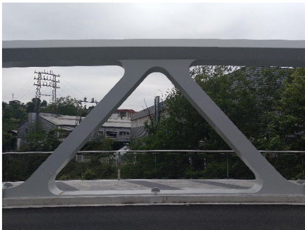
Figura 6. Alzado de triángulo formado por diagonales adyacentes y cordón inferior
