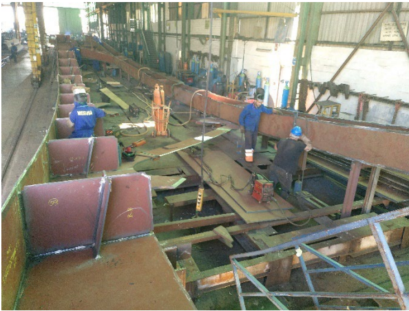
Figura 13. Proceso de ensamble en taller de una de las celosías con el lado cóncavo hacia arriba
