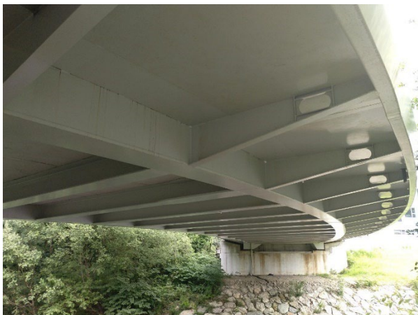
Figura 7. Perspectiva de vigas transversales, costillas de aceras y viga de borde
