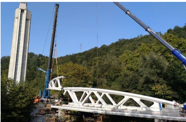
Figura 26. Montaje del tercer módulo de celosía
