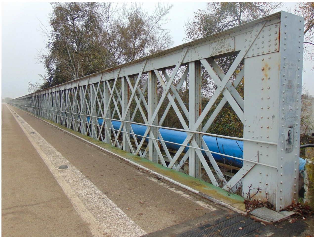
Figura 1. Vista general de una celosía desde el estribo norte.
