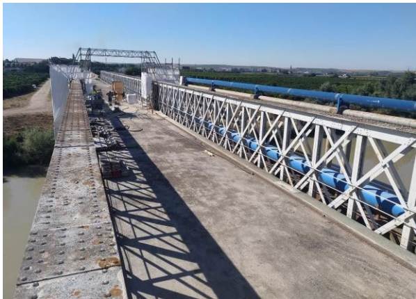
Figura 18. Vista desde el cordón superior durante trabajos de repintado
