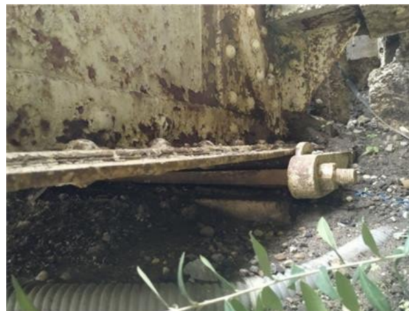
Figura 5. Aspecto de los apoyos móviles en el estribo de la margen derecha, vista frontal
