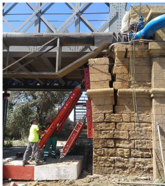
Figura 14. Apeo del paramento frontal de estribo
