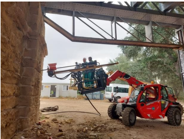
Figura 15. Ejecución de bulones en estribo norte
