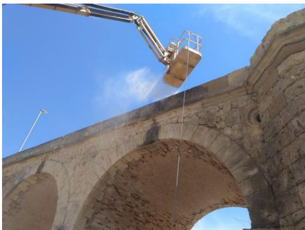
Figura 19. Limpieza de fábrica con agua nebulizada
