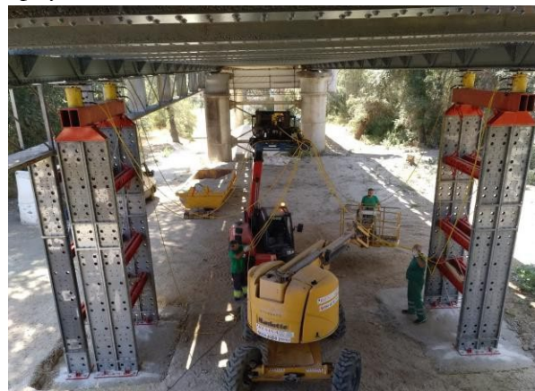
Figura 10. Apeos y gatos dispuestos en vano extremo para reparación de apoyos en estribo norte
