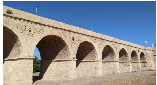
Figura 20. Aspecto del puente tras finalizar la limpieza con agua nebulizada
