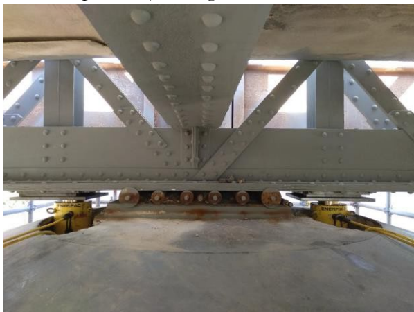
Figura 11. Gatos alojados en zonas localmente demolidas de los fustes.
