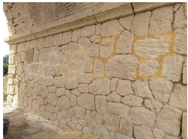
Figura 21. Pruebas de color en mortero de rejuntado
