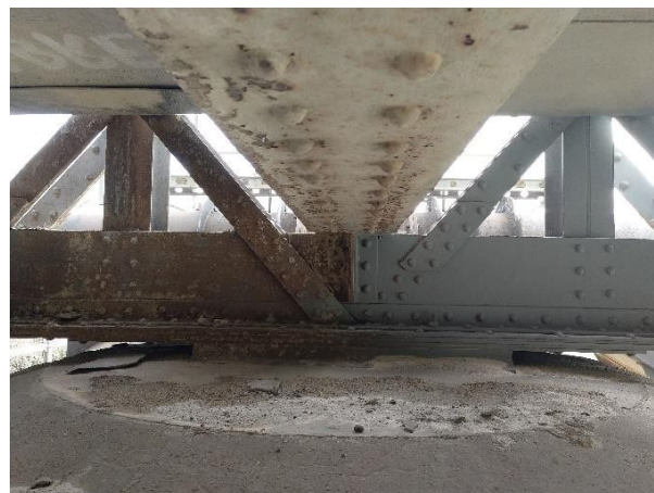
Figura 7. Izquierda, estado original y derecha, estado del cordón inferior tras repintado
