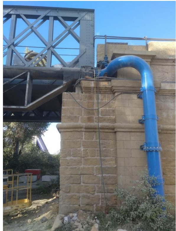
Figura 16. Lateral de estribo tras el refuerzo
