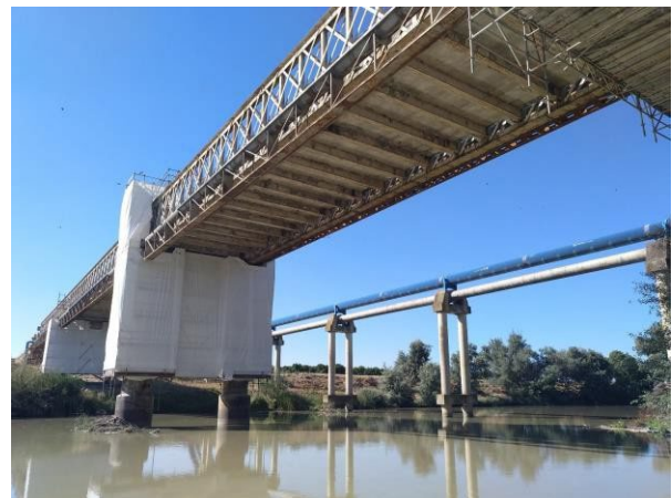
Figura 17. Vista inferior del puente durante trabajos de repintado
