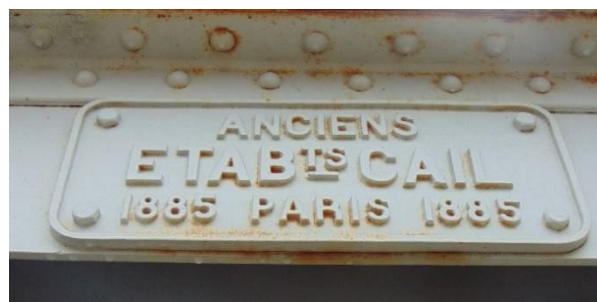
Figura 2. Chapa en cordón superior del taller metálico Cail
