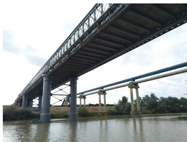
Figura 8. Vista inferior del tablero y fustes de fundición tras el repintado
