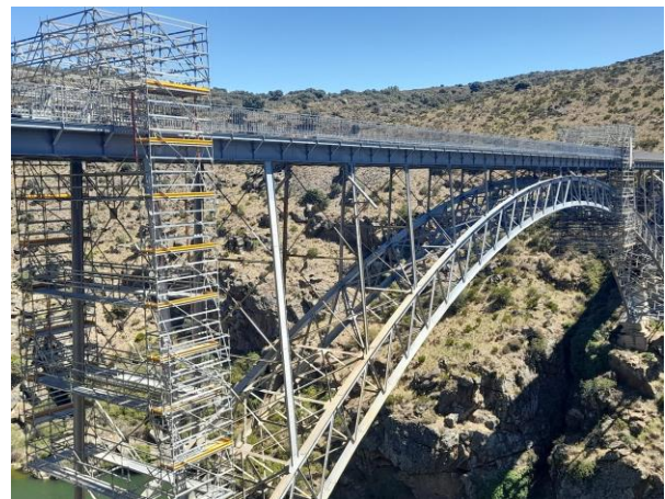
Figura 16 Instalación de dos andamios de forma simultánea en el tramo del arco
