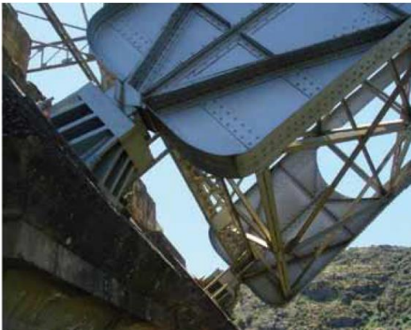
Figura 3 Detalle de apoyo de arco en cimentación [3]
