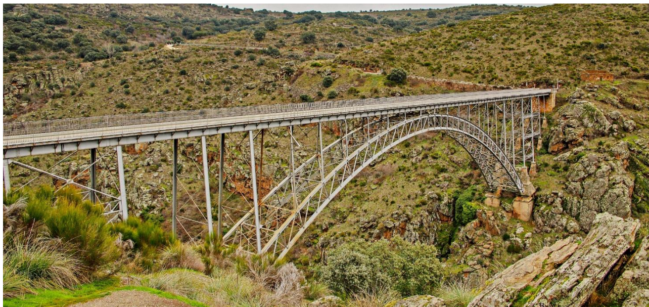
Figura 1 Vista general de Puente-Viaducto de Requejo (Puente de Pino)
