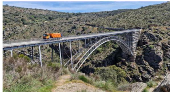
Figura 12 Realización de prueba de carga estática
