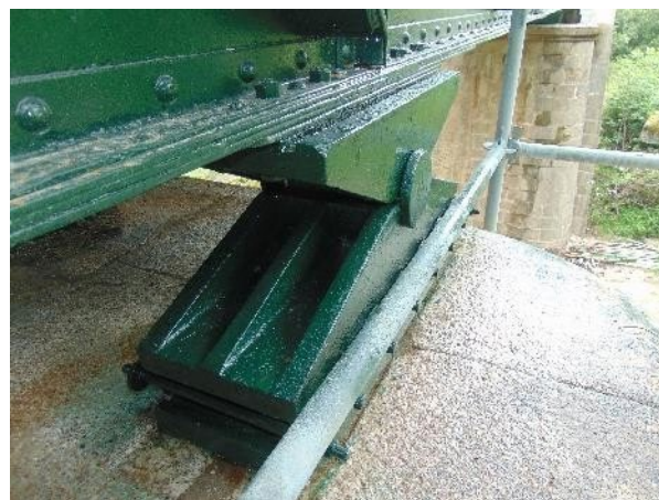
Figura 18. Vista de apoyo fijo rehabilitado
