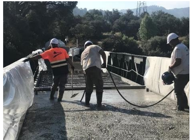
Figura 23. Vibrado de hormigón del tablero
