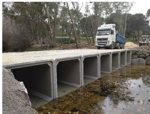
Figura 7. Ejecución del vado inundable
