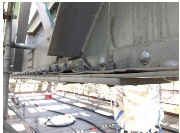
Figura 12. Refuerzo de cordón inferior
