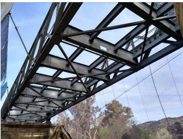
Figura 21. Vista del tablero tras la retira de los perfiles “omega”
