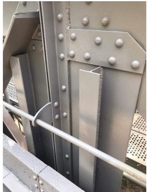
Figura 15. Refuerzo de montante de apoyos
