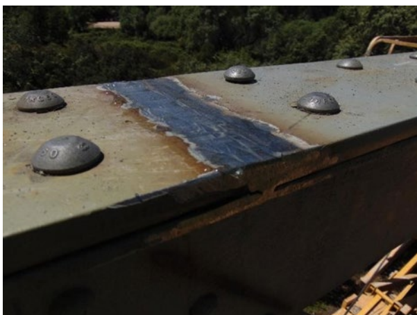
Figura 10. Empalme mediante soldadura de chapas de refuerzo de cordón superior
