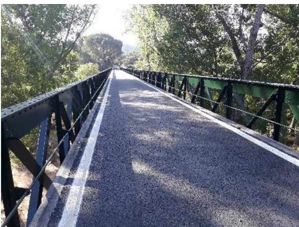
Figura 26. Vista de calzada
