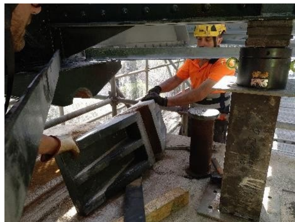
Figura 17. Vista de proceso de retirada de apoyo fijo
