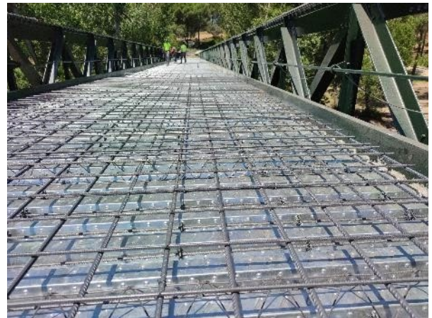
Figura 22. Chapa colaborante y ferralla
