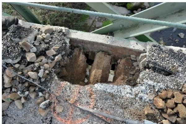
Figura 5. Vista de calicata en el tablero
