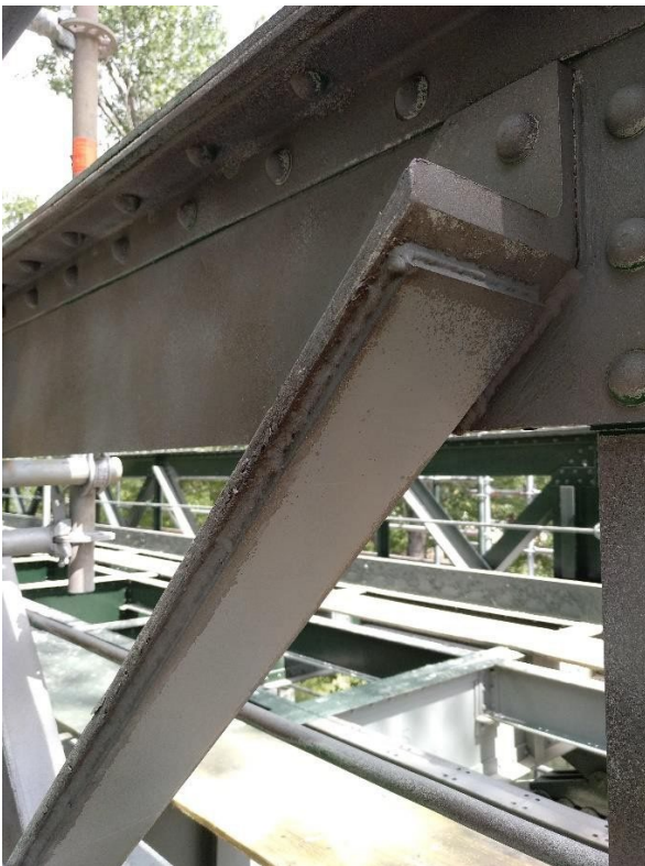
Figura 14. Refuerzo de diagonales
