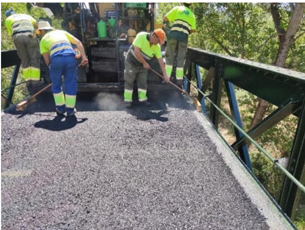
Figura 25. Extendido de aglomerado
