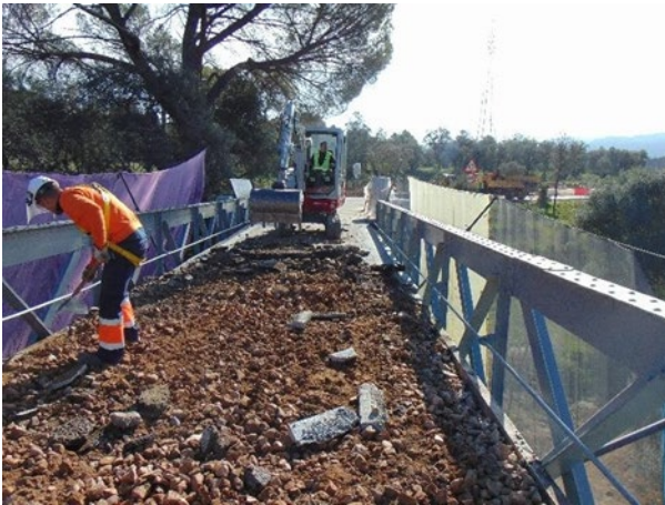
Figura 19. Demolición del pavimento
