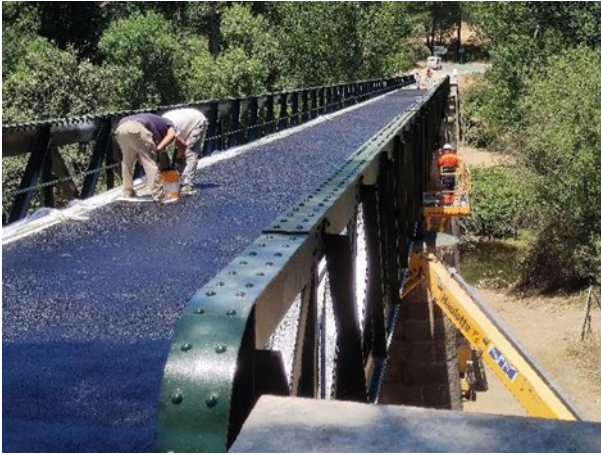
Figura 24. Impermeabilización del tablero
