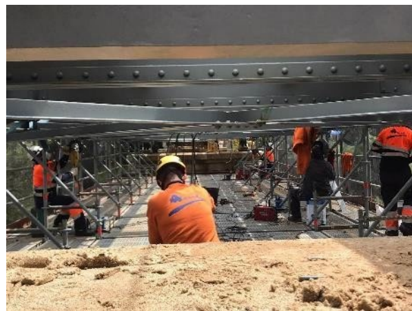
Figura 8. Andamio instalado en tablero
