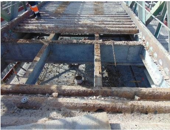
Figura 20. Retirada de perfiles “omega”
