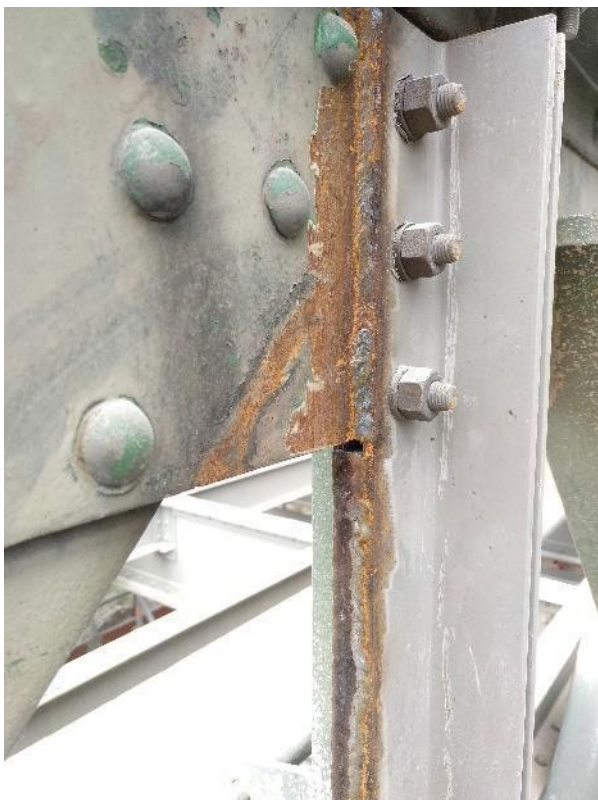
Figura 16. Refuerzo de montante
