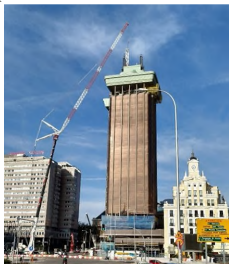
Figura 2. Montaje de grúa sobre torres originales
