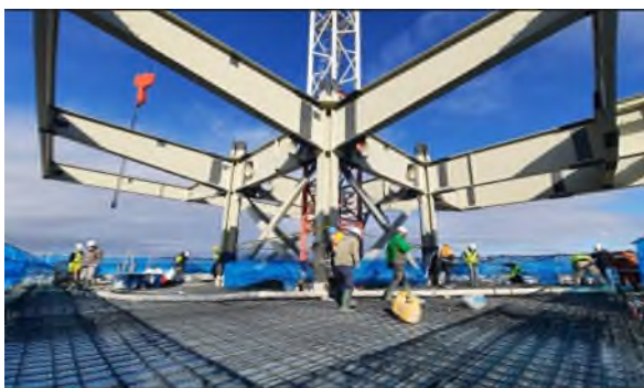
Figura 10. Estructura metálica de remonta
