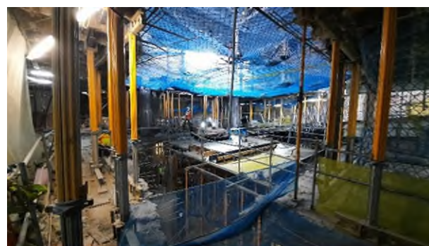
Figura 8. Perímetro apuntalado en la huella del nuevo núcleo.
