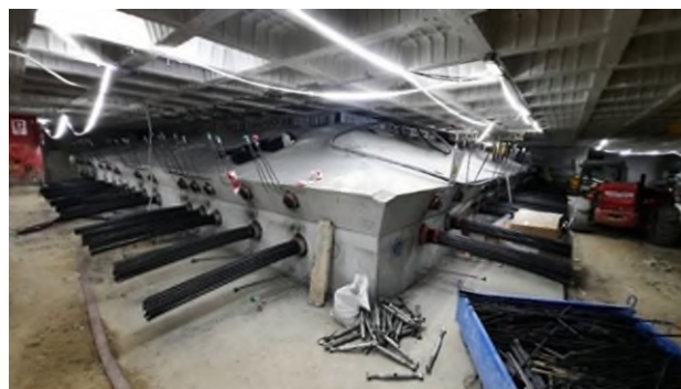
Figura 6. Vista del encepado de recalce de los núcleos existentes antes y después del hormigonado.
