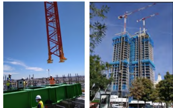
Figura 5. Maniobra de posicionamiento de la grúa sobre bastidor de cubierta y vista general de ambas grúas.
