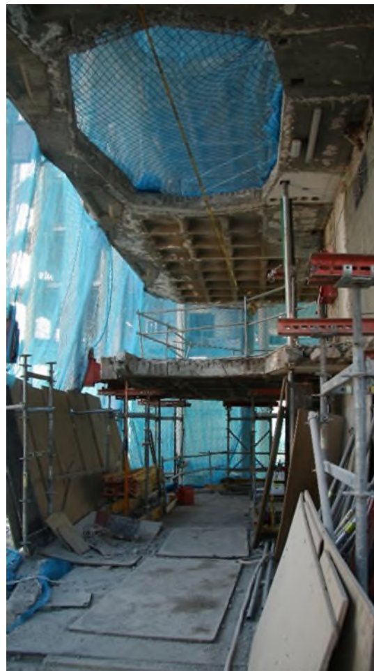
Figura 12. Demolición de planta 5ª colgada
