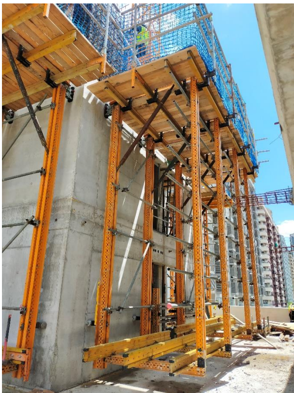
Figura 11. Encofrado trepante Torre C
