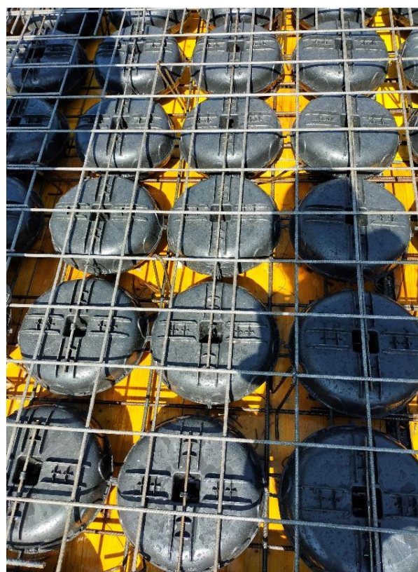
Figura 2. Detalle aligeramientos colocados en obra.
