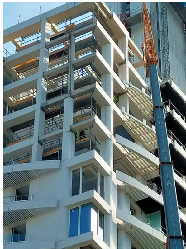
Figura 12. Izado y posicionamiento de peines metálicos
