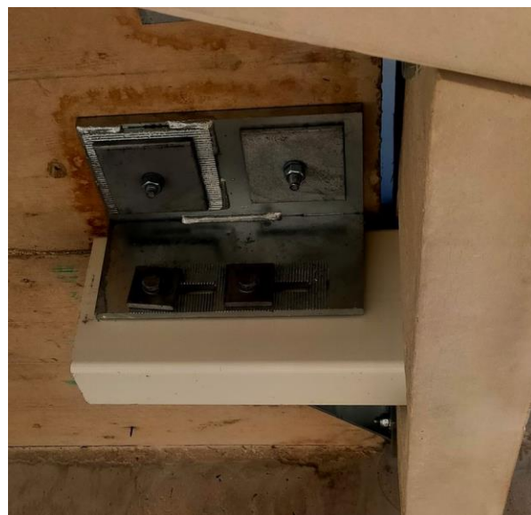
Figura 13. Detalle pieza de anclaje peines a estructura
