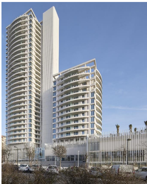
Figura 14. Vista general obra terminada
