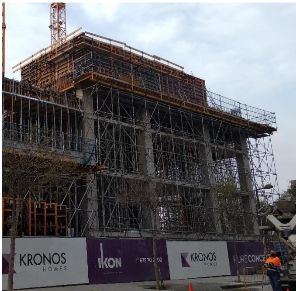
Figura 8. Cimbra para hormigonado de viga puente.
