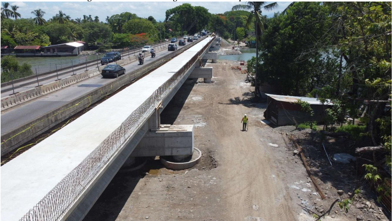
Figura 13. Tablero de fase 2 de proceso constructivo hormigonado.
