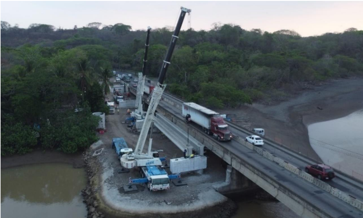
Figura 12. Colocación de vigas de la fase 2 del proceso constructivo.
