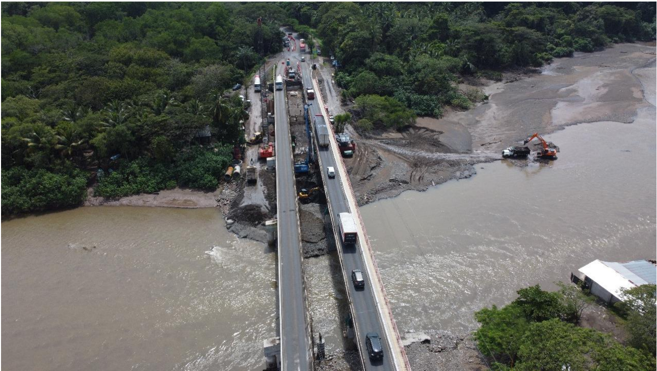
Figura 14. Trabajos de ejecución del pilote central de la fase 6 del proceso constructivo.
