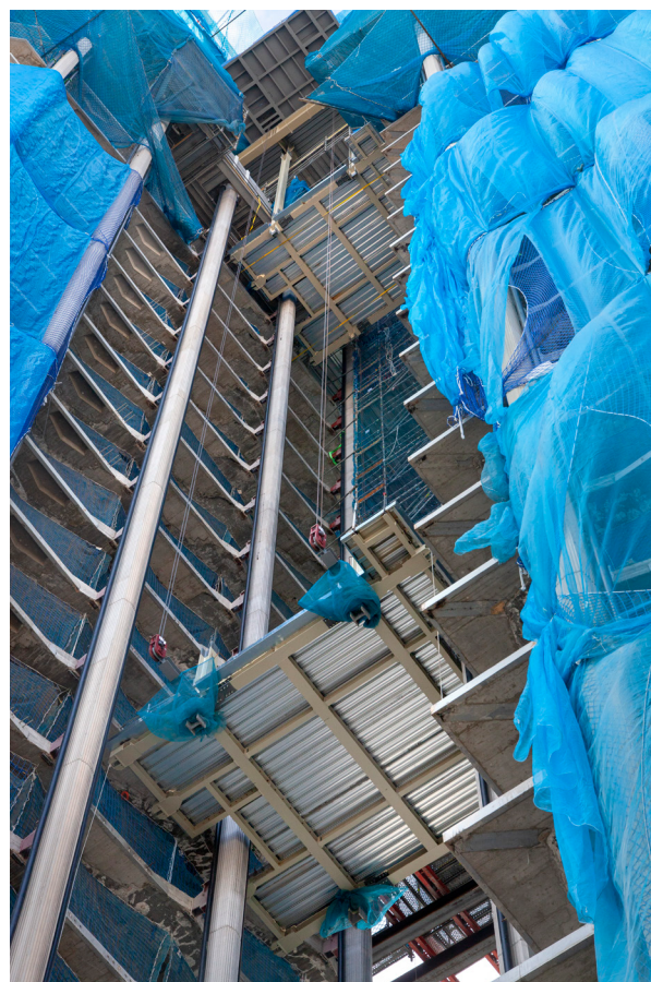
Figura 23. Izaje vestíbulos colgados
