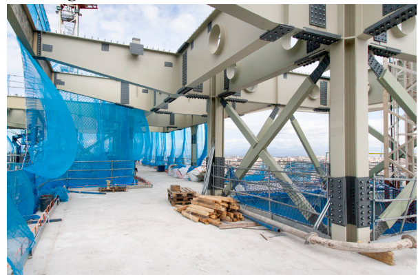
Figura 6. Estructura metálica de remonta
