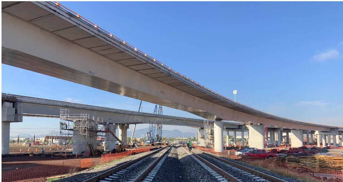
Figura 3. Vista de Viaductos 1 y 2 cruzando sobre el FFCC.
