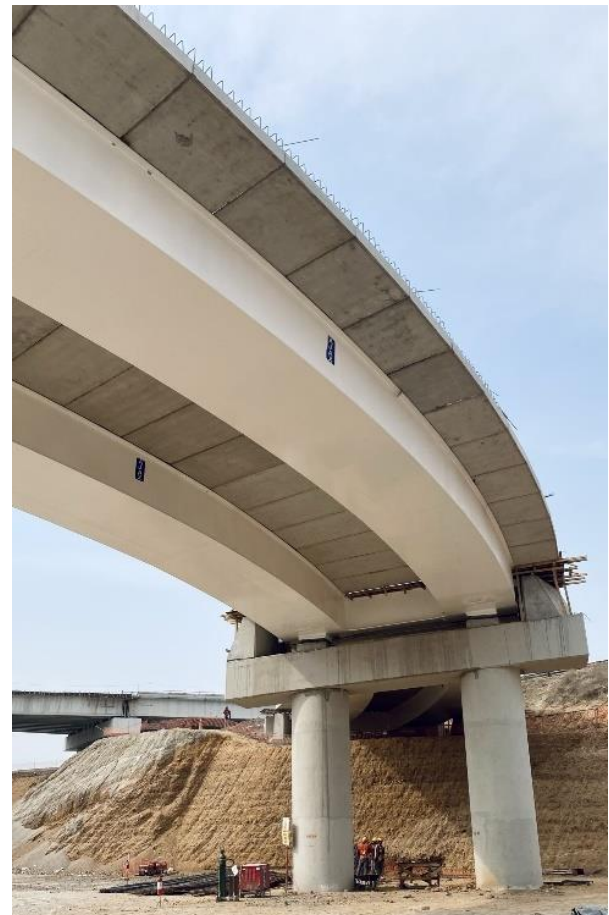
Figura 9. Vista inferior en construcción del Viaducto Eje 300.
