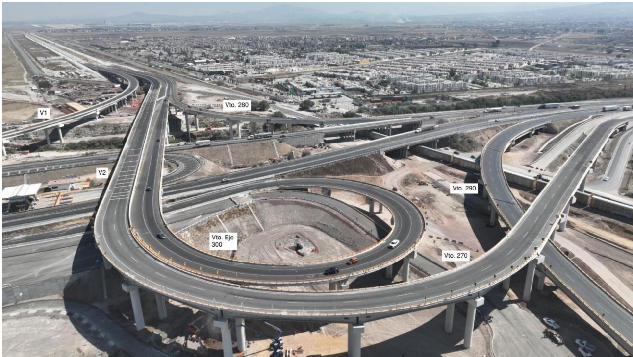
Figura 2. Vista aérea de estructuras desde Viaductos 270 y Eje 300.
