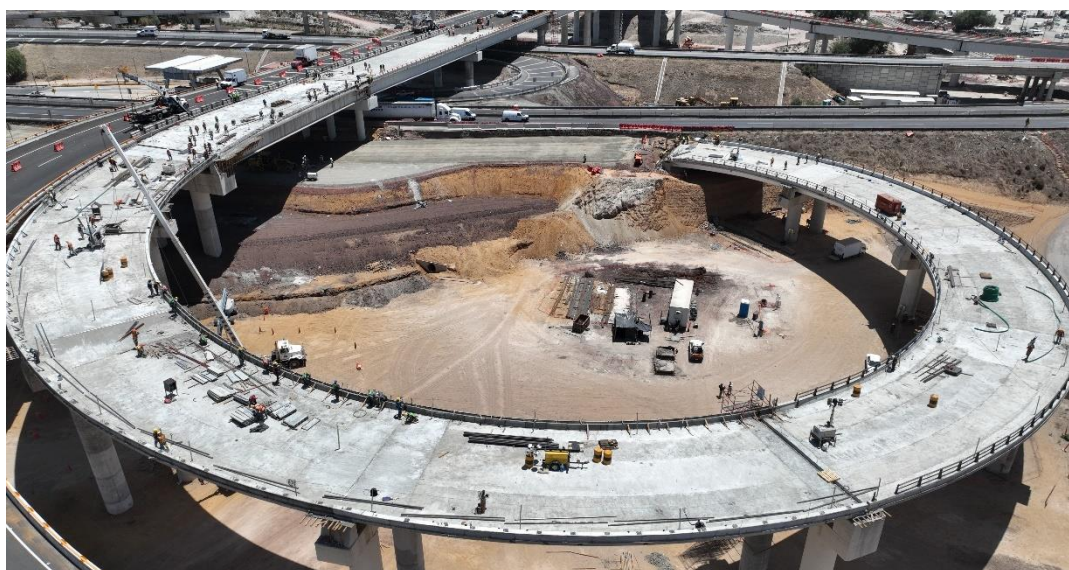
Figura 10. Vista superior mostrando losa y juntas del Viaducto Eje 300.
