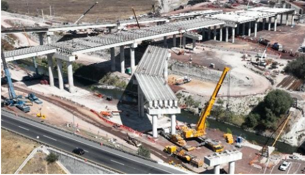
Figura 12. Vista del Viaducto 280 en construcción.
