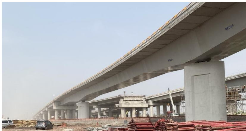
Figura 4. Vista en primer plano del Viaductos 1 en cruce sobre el FFCC.
