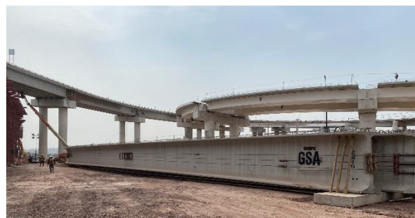
Figura 11. Acopio de vigas Nebraska 240 para Viaducto 290.
