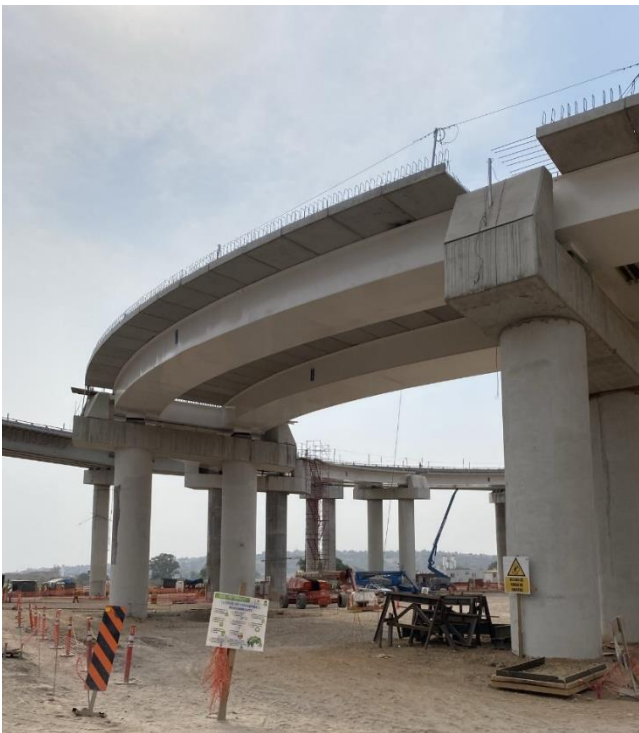
Figura 8. Vista de los doubles cajones metálicos isostáticos en el Viaducto Eje 300.
