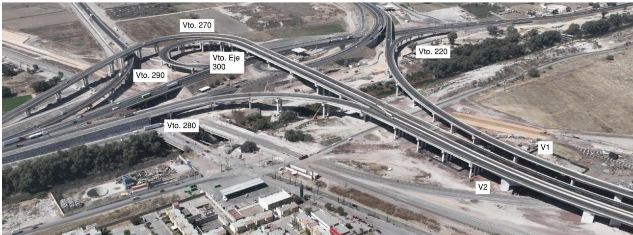
Figura 1. Vista general de estructuras del Enlace AIFA.
