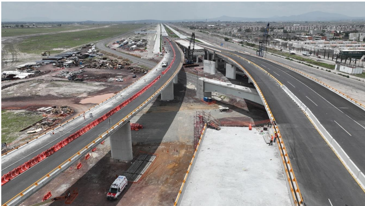
Figura 6. Vista de Viaducto 1 (izquierda) y Viaducto 2 en construcción, mostrando la pila pórtico mixta junto al FFCC.
