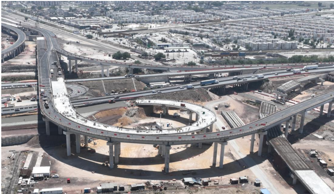
Figura 7. Vista aérea parcial del enlace AIFA, con el Viaducto Eje 300 en construcción en el centro.
