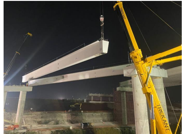
Figura 13. Vista del izado de las vigas cajón de 54m del Viaducto 280.
