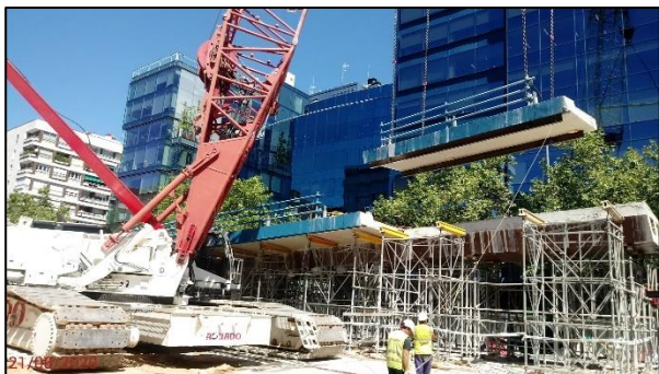
Figura 8. Demolición de un puente en Madrid, afectado por reacciones árido-álcali
