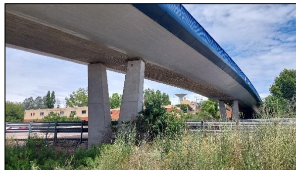
Figura 9. Puente en Valladolid tratado en 2015 con sistema de impermeabilización de tipo poliuretano-metacrilato en cara superior y almas, con tratamiento hidrofugante en tabla inferior (imagen tomada en 2024)
