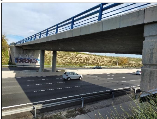
Figura 1. Vista general del puente tipo en el que se identifica con mayor frecuencia la patología descrita.
