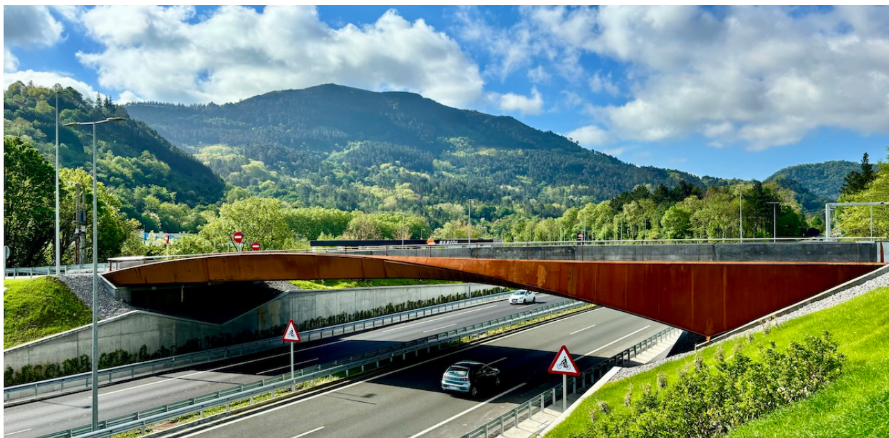
Figura 14. Puente Sur Allerru.
