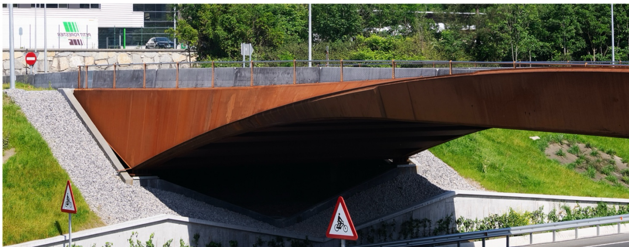
Figura 6. Estribo de empotramiento.
