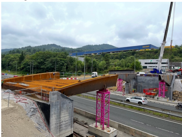
Figura 13. Montaje en obra por tramos sobre apoyos provisionales.
