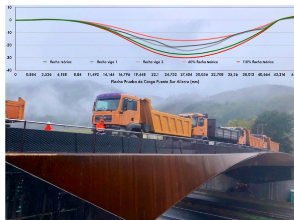
Figura 11. Prueba de carga y gráfica de resultados del puente Sur
