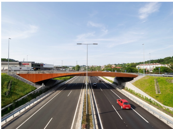
Figura 3. Muros de en diente de sierra y parterres vegetalizados.
