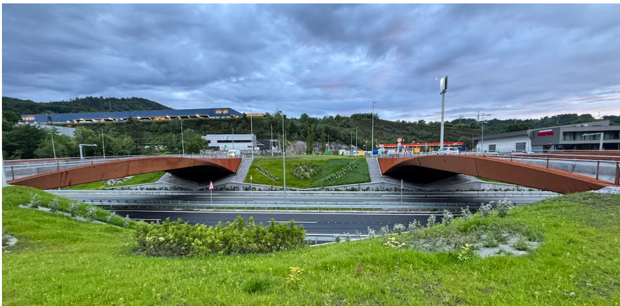
Figura 1. Rotonda elevada de Allerru sobre la N-I.
