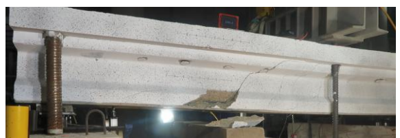
a) Rotura a cortante en viga D a 365 kN
