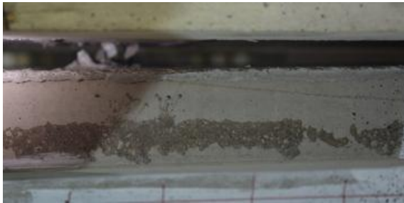
b) Rotura del cerco de GFRP por rasante
