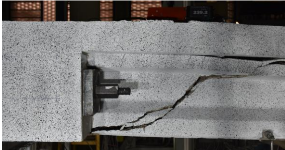
a) Rotura a cortante en el apoyo intermedio a 289.5 kN
