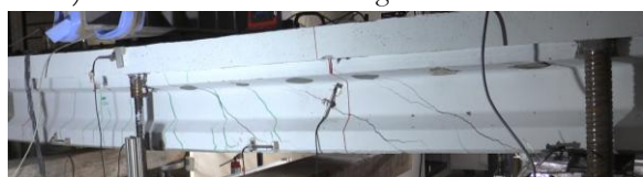
b) Instante antes de rotura – viga C
