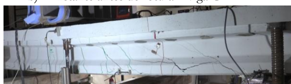
c) Rotura a cortante en viga C a 407 kN
