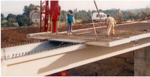
Figura 1. Tablero de viga HP y losa “in situ” de HA.
