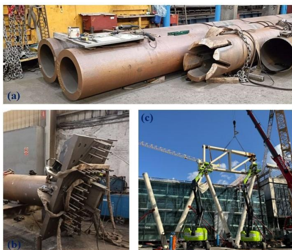
Figura 8. Tubos de Vs (a), placa de anclaje (b) y montaje de celosía cargadero (c).
