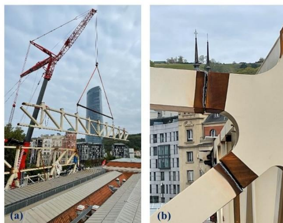
Figura 11. Izado (a) y posicionamiento (b) del tramo inferior (P4-P5) de la celosía I.
