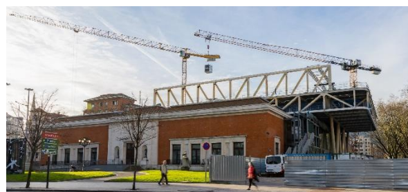
Figura 12. Celosías principales completas A y C.
