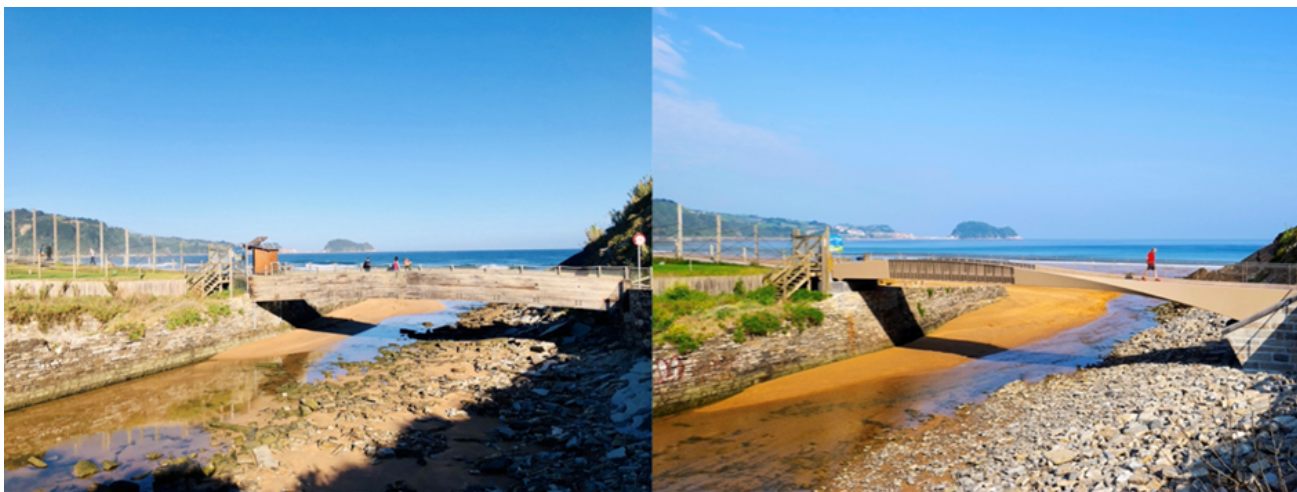
Figura 3. Antigua pasarela de madera (izquierda) y nueva pasarela metálica (derecha).
