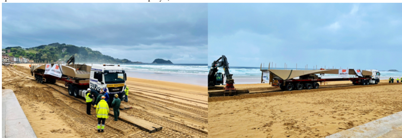
Figura 11. Transporte por la playa sobre tablones de madera.
