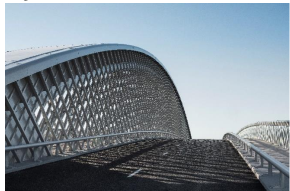
Figura 2. Vista general de la plataforma del tablero, arco, diagrid e imposta del Puente de la Concordia.
