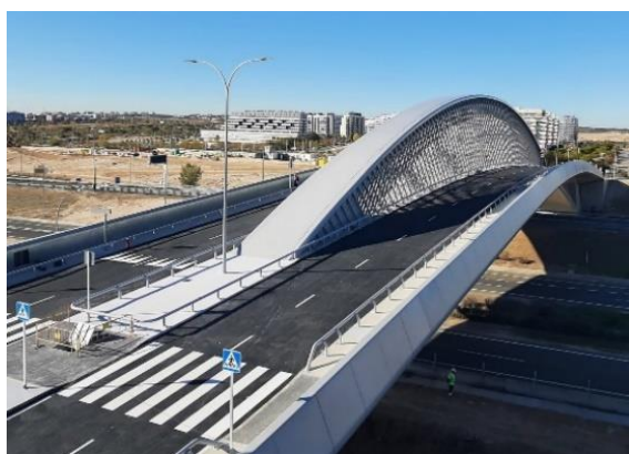
Figura 24. Vista general del Puente de la Concordia.
