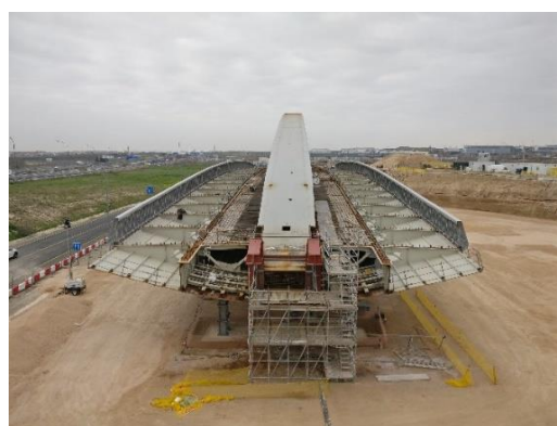
Figura 13. Montaje de la estructura metálica en obra.
