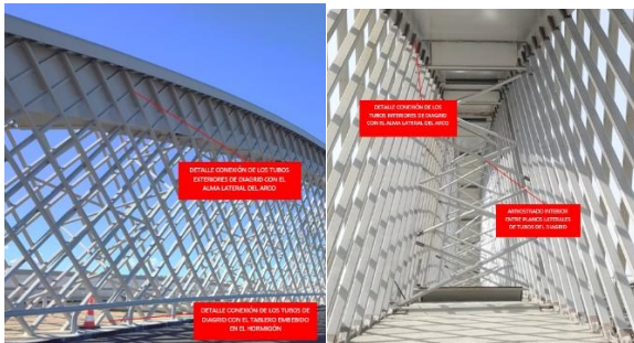
Figura 18. Detalles de diagrid.
