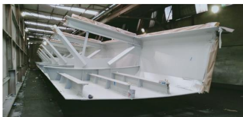
Figura 21. Pintura de subconjunto del tablero.
