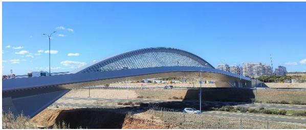
Figura 1. Vista general del Puente de la Concordia.
