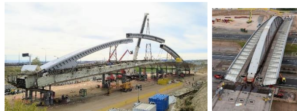
Figura 22. Control geométrico durante el montaje
