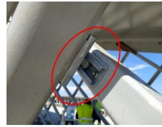
Figura 19. Detalle conexión local entre tubos.
