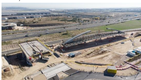
Figura 12. Montaje de estructura metálica en obra.
