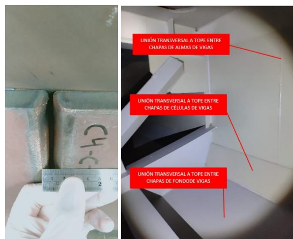
Figura 17. Detalles de uniones a tope en tablero.
