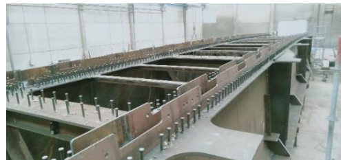
Figura 20. Detalle de transición curva en despiece de chapas de platabanda superior.
