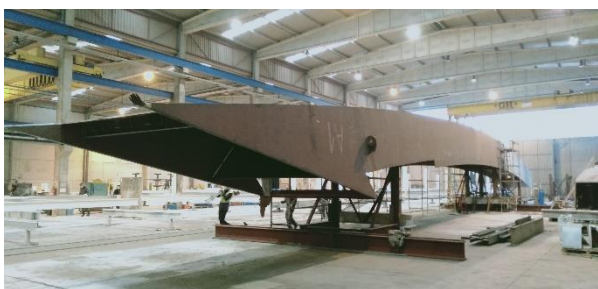
Figura 7. Fabricación de un subconjunto del arco.
