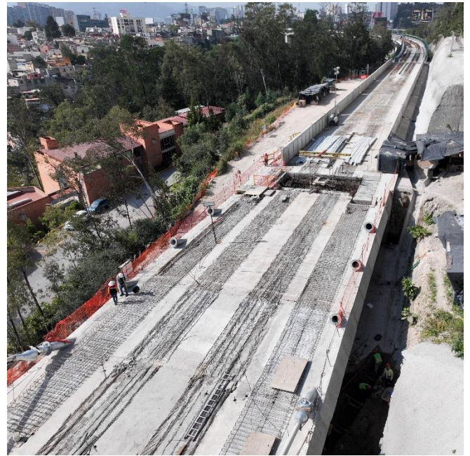
Figura 9. Tubos de los tirantes en la zona del estribo
