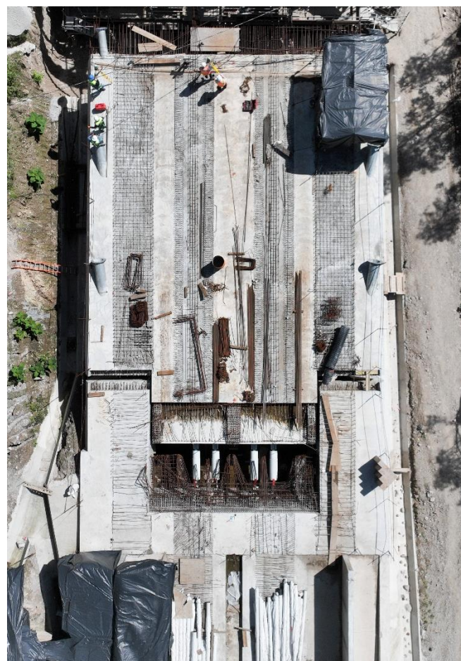
Figura 6. Vista superior de la zona de estribo con los amortiguadores
