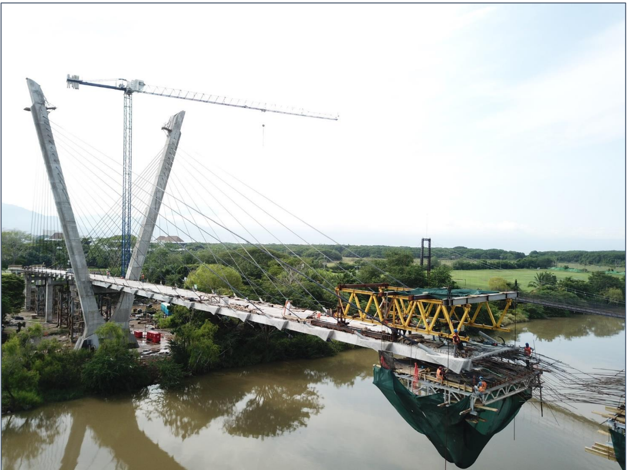
Figura 10. Construcción del vano central.
