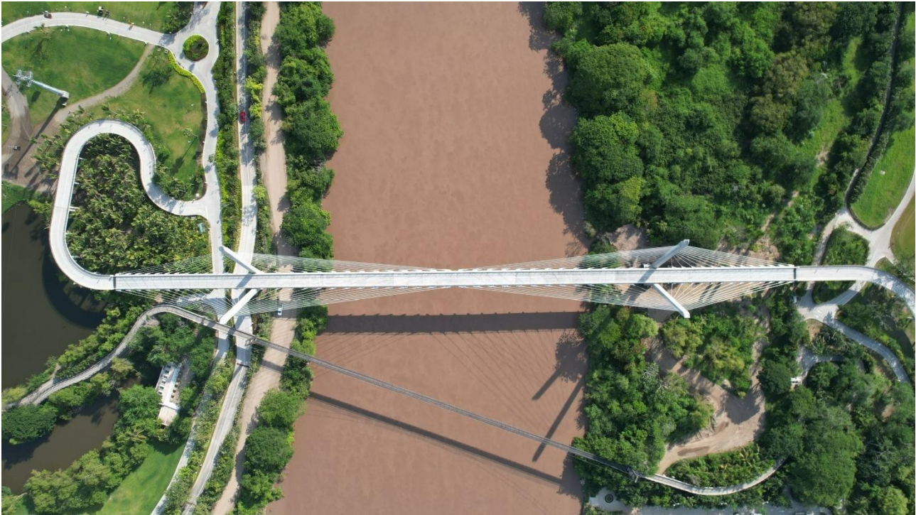
Figura 4. Vista aérea de la pasarela completa.
