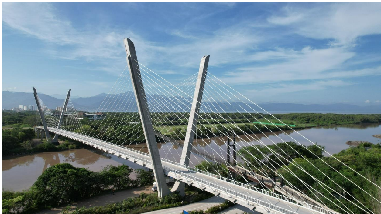
Figura 6. Vista general de la pasarela y las torres de atirantamiento.
