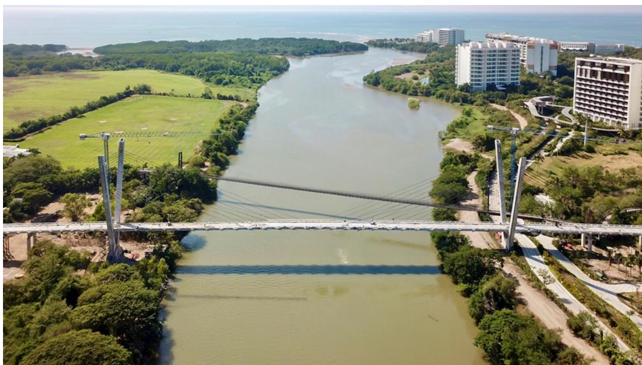
Figura 1. Vista general de la pasarela.
