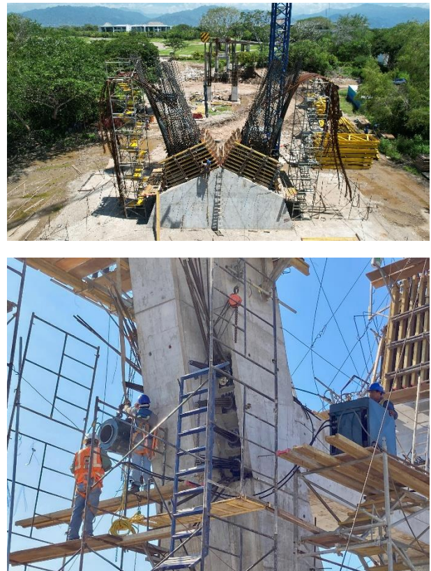
Figura 8. Pretensado de las torres.
