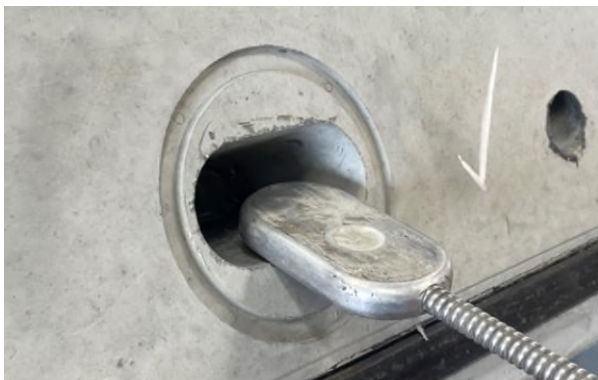
Figura 11. Revisión de no obstrucción de vainas mediante pieza de plástico unida a varilla flexible
