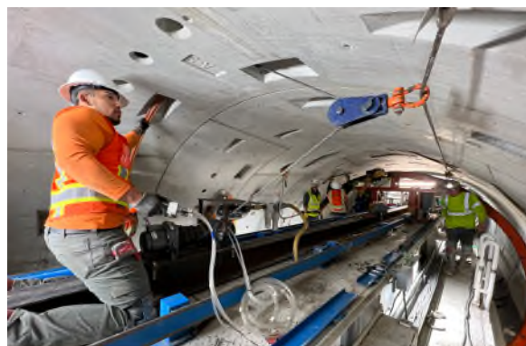
Figura 13. Enfilado de las dovelas con cabestrante
