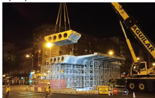
Figura 7. Retirada de una pieza de núcleo tablero.
