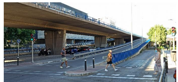
Figura 3. Aspecto del cruce de la calle Pedro Bosch con la Avda. Ciudad de Barcelona antes
