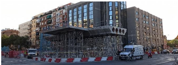
Figura 5. Proceso de demolición fuertemente influido por el entorno urbano
