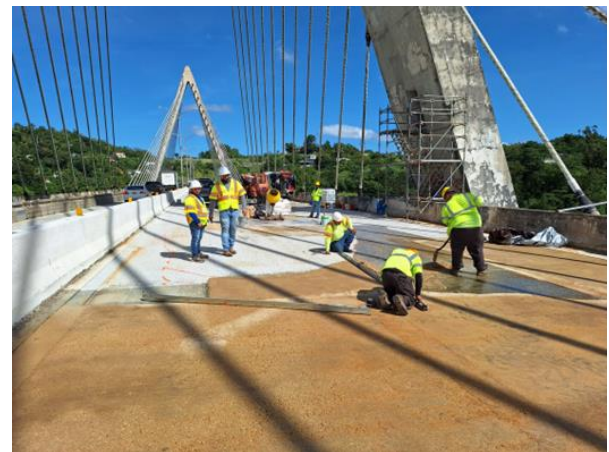
Figura 19. Aplicación del mortero polimérico
