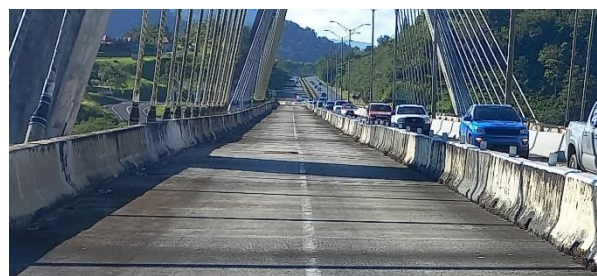
Figura 4. Vista de la calzada previa a la actuación
