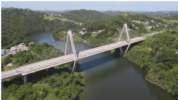
Figura 1. Vista general del puente de Naranjito
