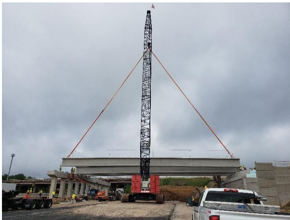
Figura 7. Colocación de las vigas del puente B617.
