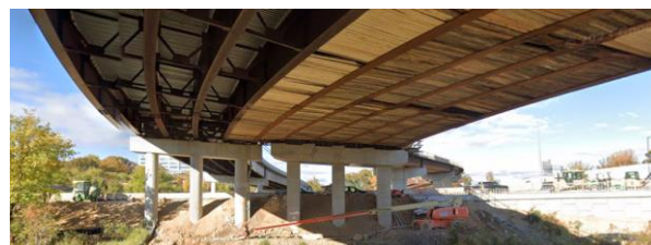
Figura 14. Vista general del B629 (Unit 3) una vez realizada la ampliación.
