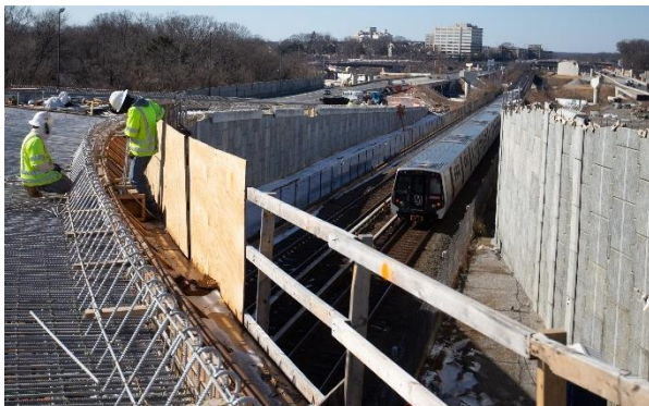
Figura 11. Vista general de la construcción de los muros de los puentes B624 y B625 junto a WMATA.
