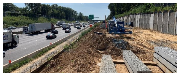
Figura 10. Vista general de la construcción de los muros paralelos a la I-66 (WB).
