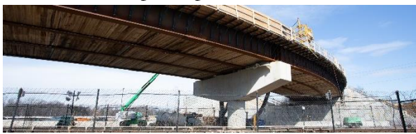
Figura 16. Vista general de la pila martillo del B624.
