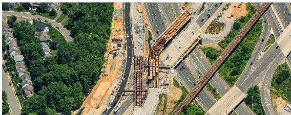
Figura 6. Vista general de la construcción de los puentes B628 y B679.
