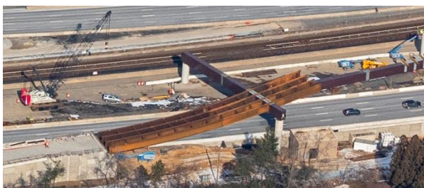
Figura 17. Vista general de la construcción de los pórticos metálicos del B678.
