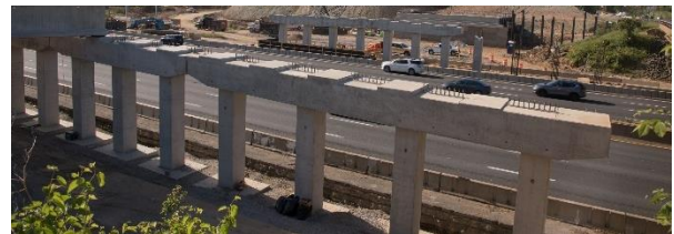
Figura 18. Vista general de la pila multifuste del puente B617.
