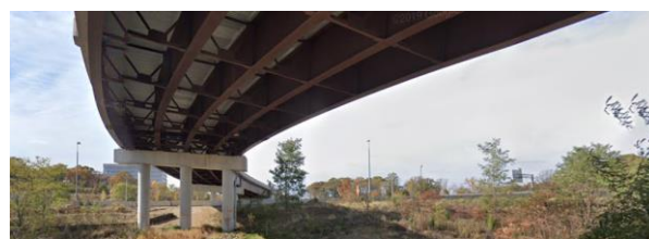
Figura 13. Vista general del B629 (Unit 3) antes de la ampliación.
