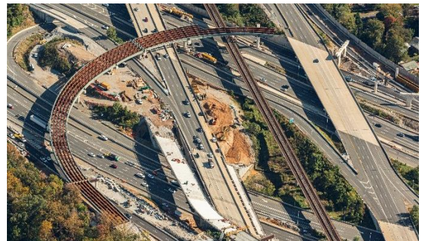
Figura 4. Vista general de la construcción de las estructuras de la I-66 en el cruce con la I-495
