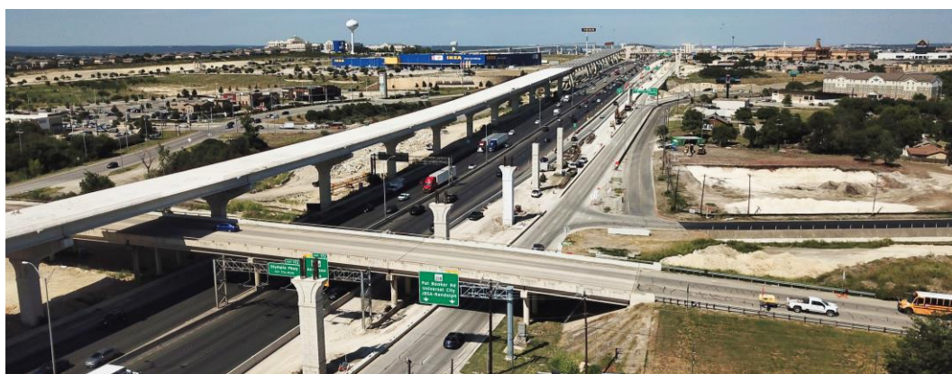
Figura 1. Vista general de las obras de ampliación con calzadas elevadas de la autopista I-35 NEX Central.
