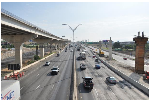
Figura 3. Detalle de pilas situadas en tercianas
