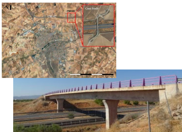
Figura 2. Caso de estudio: localización y fotografía de la estructura real.
