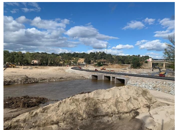
Figura 12. Vista del paso provisional sobre el río.
