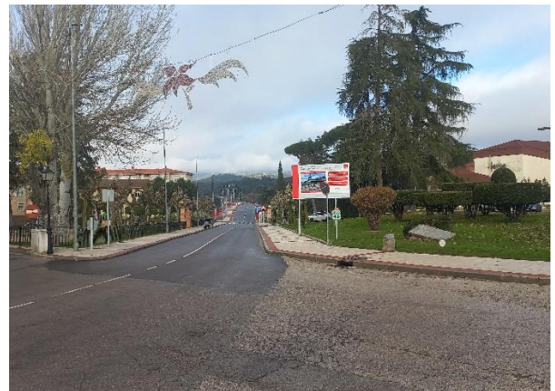
Figura 22. Vista del lomo de asno de la nueva plataforma.
