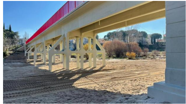
Figura 4. Vista del puente tras la rehabilitación de 2021.
