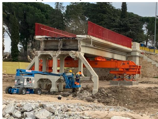
Figura 8. Vista del apeo de la ruina del tablero.
