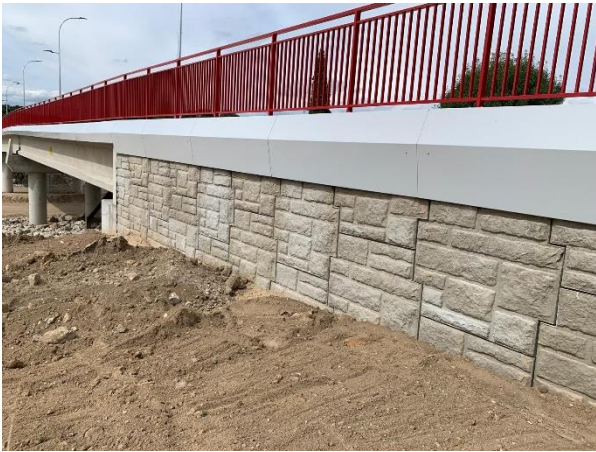
Figura 19. Muros de tierra armada texturizados.
