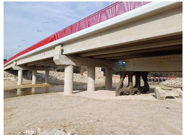
Figura 18. Vista del nuevo puente. En primer plano ruina del puente histórico.
