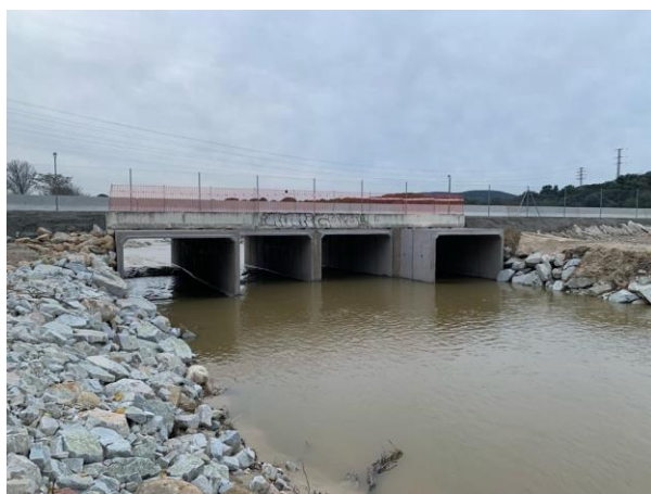
Figura 13. Vista de los marcos.
