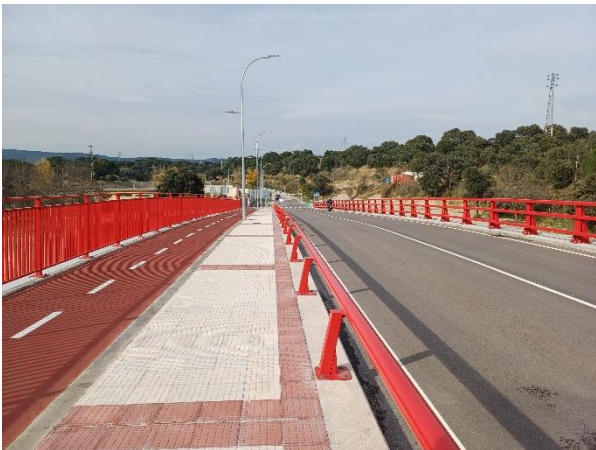
Figura 20. Vista de la nueva plataforma.
