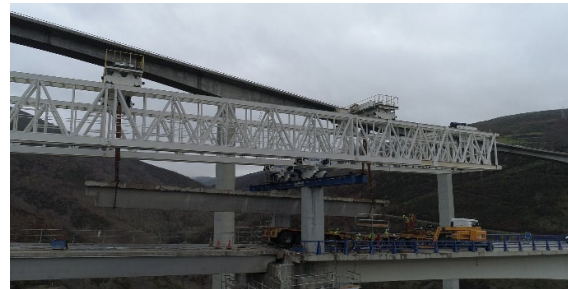
Figura 16 Retirada de las vigas del vano 7 y descenso sobre camión situado en vano 6 del viaducto
