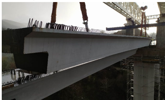
Figura 19 Instalación de nuevas vigas artesas
