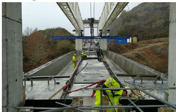
Figura 20 Vista de las vigas en posición
