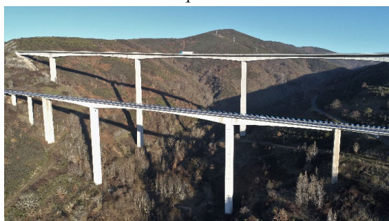
Figura 1 Vista general de la estructura (Viaducto de Ruitelán al frente y Viaducto de Sanprón al fondo)
