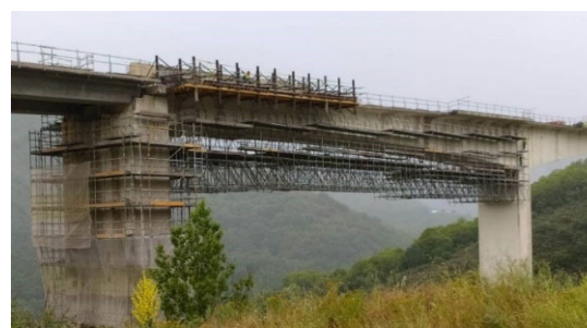
Figura 25 Andamio colgado instalado en el vano 4 para trabajos de reparación
