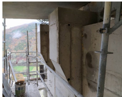
Figura 22 Vista de las ménsulas cortas ejecutadas en la pila P-3 para permitir alojar los gatos
