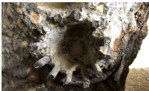
Figura 9 Detalle del sistema de pretensado existente
