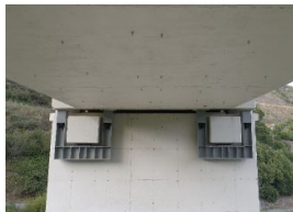
Figura 27 Vista del tope transversal y elemento de retenida
