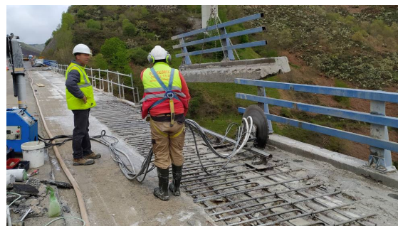
Figura 29. Proceso de corte de voladizo tras hidrodemolición.
