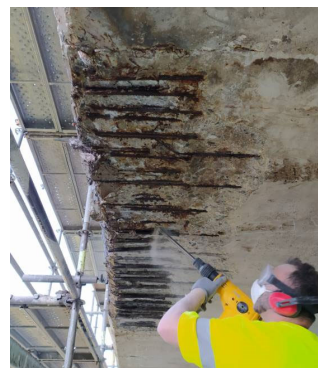
Figura 24 Saneo de daños en el tablero
