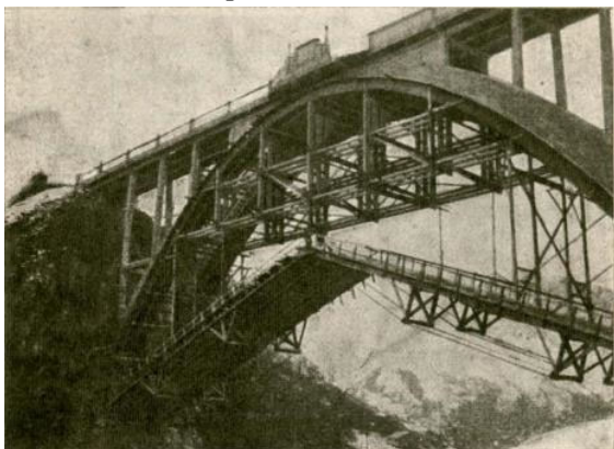
Figura 1. Cimbra provisional para la ejecución de un puente arco de hormigón
