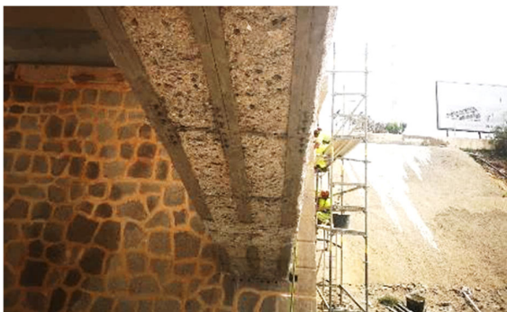
Figura 14. Vista de arco tras el picado superficial y la pasivación de perfiles metálicos de la celosía.
