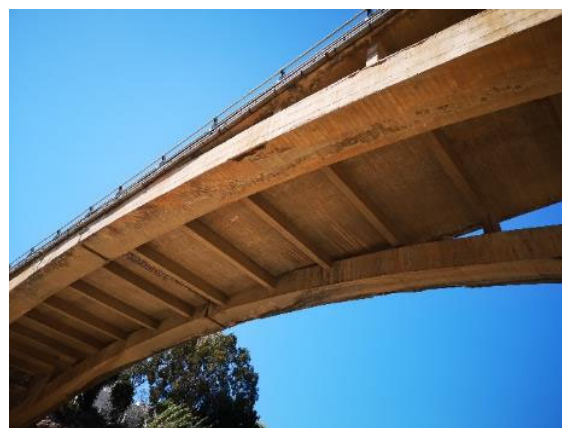
Figura 8. Vista general inferior del tablero
