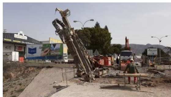
Figura 25. Detalle de ejecución de inyecciones
