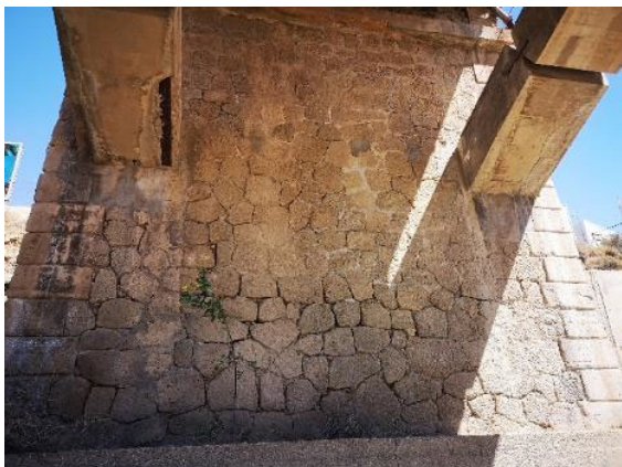
Figura 9. Lavado y apertura de llagas en estribos
