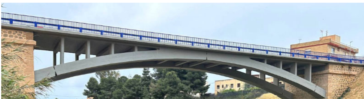
Figura 27. Detalle de acabado de arco tras tratamiento de pintura final
