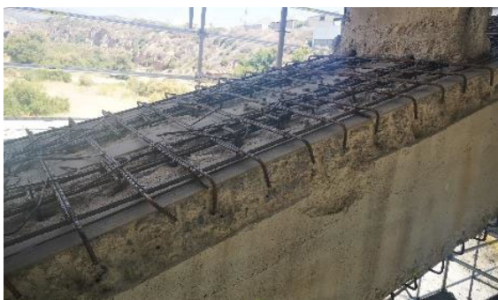
Figura 15. Vista de ferrallado de arco
