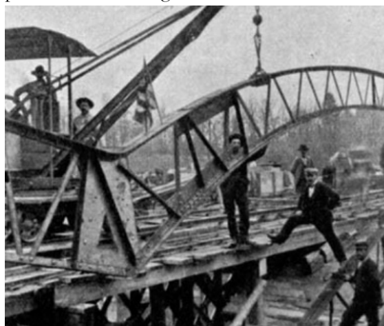
Figura 2. Puente «Chauderon-Montbenon», ensamblaje de la celosía metálica. (Melan 1911)
