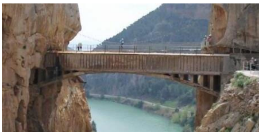
Figura 4. Acueducto de El Chorro (1904)
