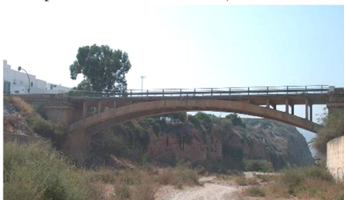
Figura 5. Vista general de la estructura
