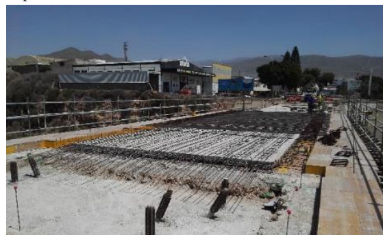
Figura 24. Detalle de micropilotes de losa sobre estribos
