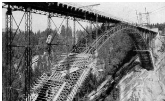
Figura 3. Puente de Echelsbach, la estructura de acero con una parte del encofrado (Duell y Gerhart 1929)
