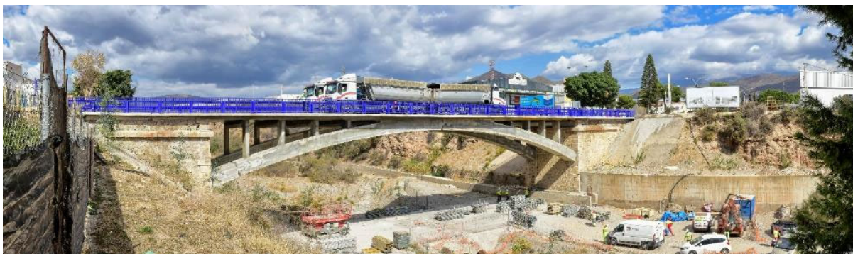
Figura 26. Detalle de realización de prueba de carga
