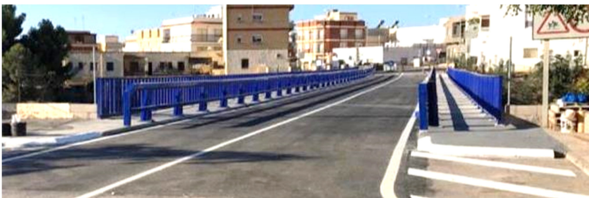
Figura 22. Vista general de plataforma tras ampliación
