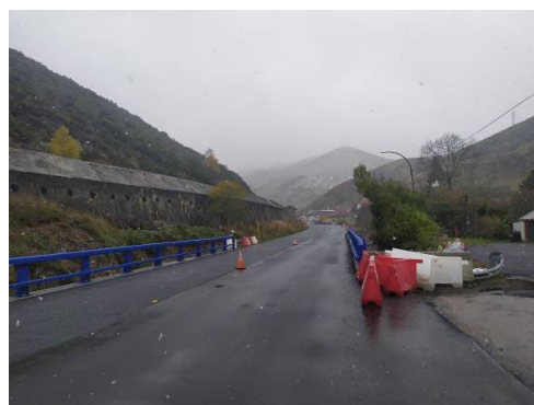
Figura 18 Vista de la plataforma
