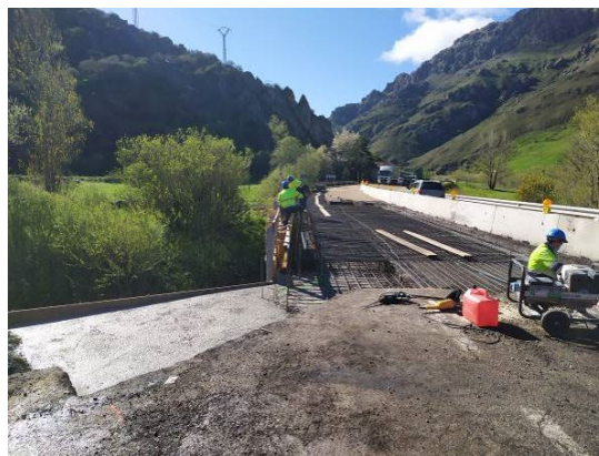
Figura 35 Ejecución de losa sobre la estructura del PK 93+525 para anclaje del sistema de contención
