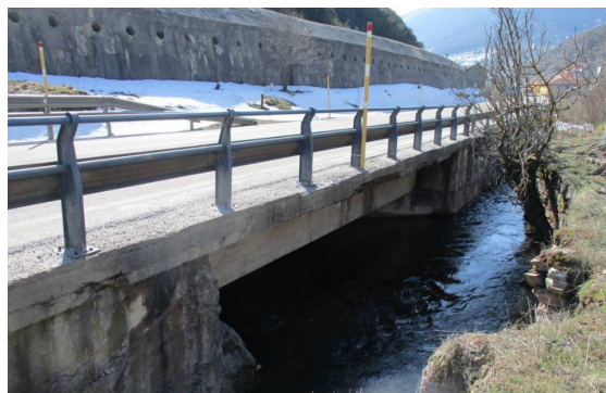
Figura 1 Vista general de la estructura situada en el PK 91+270
