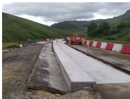
Figura 36 Losa de hormigón para anclaje del sistema de contención
