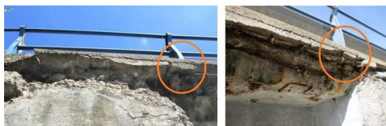
Figura 22 Vista de la cara inferior del voladizo y zona de anclaje del sistema de contención
