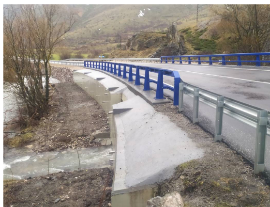
Figura 37 Vista del sistema de contención instalado en el PK 96+100
