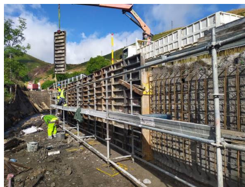
Figura 19 Reparación de muros laterales
