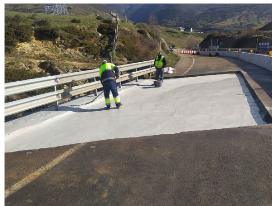
Figura 5 Impermeabilización de la bóveda
