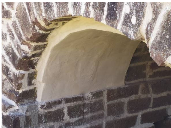
Figura 33 Reparación de zonas con descuelgue de sillares
