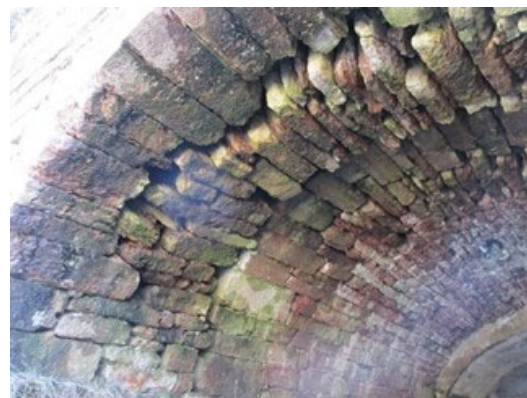
Figura 26 Lavado de llagas y descuelgue parcial de sillares
