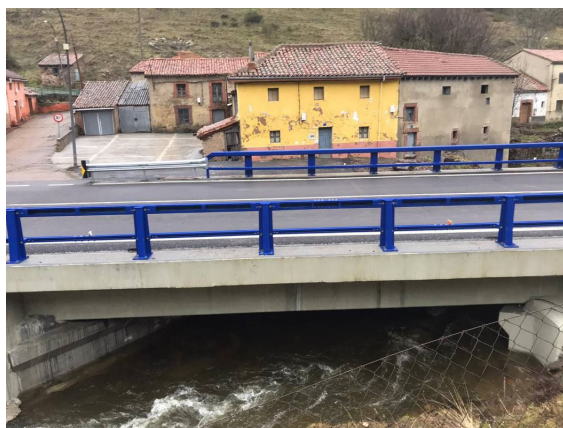
Figura 23 Vista de la estructura tras las actuaciones de reparación
