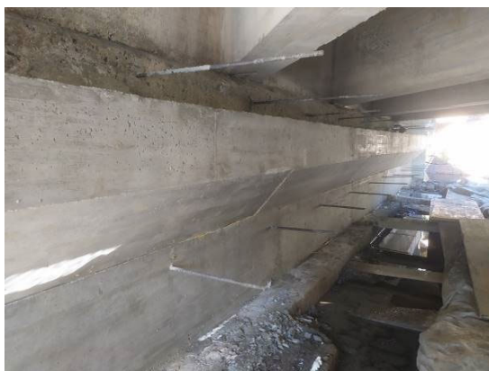
Figura 17 Ménsula corta para apoyo de gatos hidráulicos
