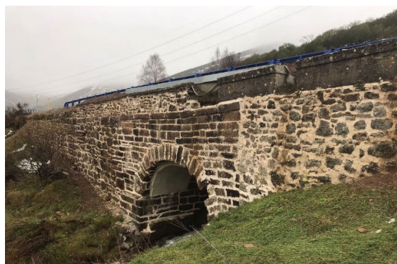
Figura 31 Vista de la estructura del PK 89+500 tras el rejuntado de llagas
