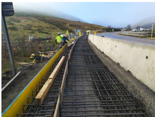
Figura 7 Ejecución de la losa de hormigón
