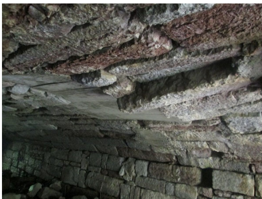
Figura 27 Lavado de llagas y descuelgue parcial de sillares
