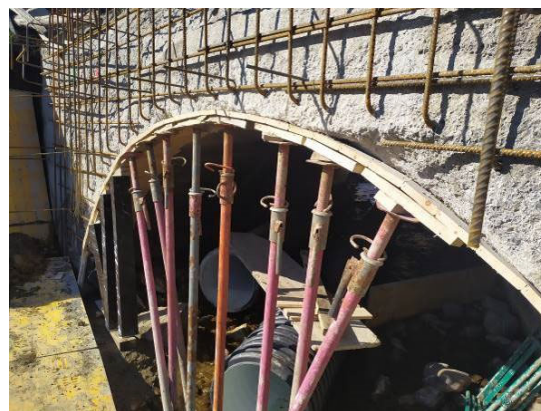
Figura 6 Reconstrucción de paramentos de hormigón degradados
