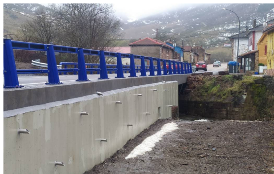
Figura 24 Vista de la estructura tras las actuaciones de reparación
