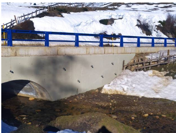
Figura 8 Vista general de la estructura tras las actuaciones de reparación
