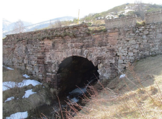
Figura 25 Vista general de una de la bóveda situada en el PK 89+500
