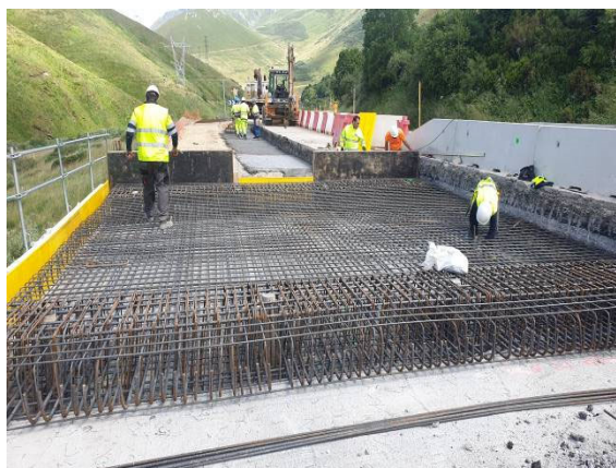
Figura 34 Ejecución de losa micropilotada
