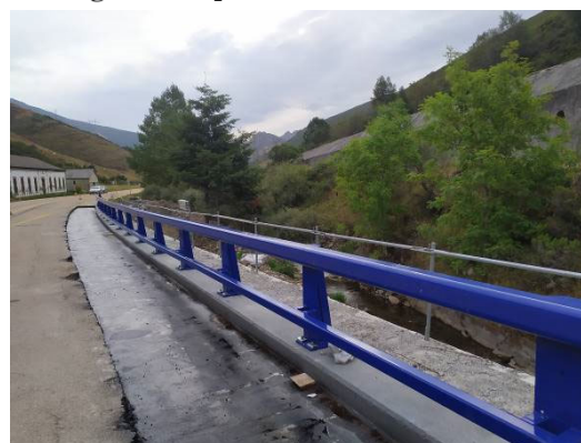
Figura 20 Losa para anclaje del sistema de contención en accesos
