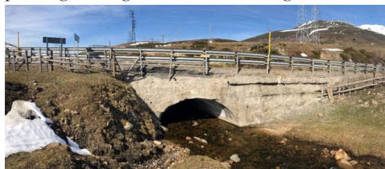
Figura 2 Vista general de la estructura
