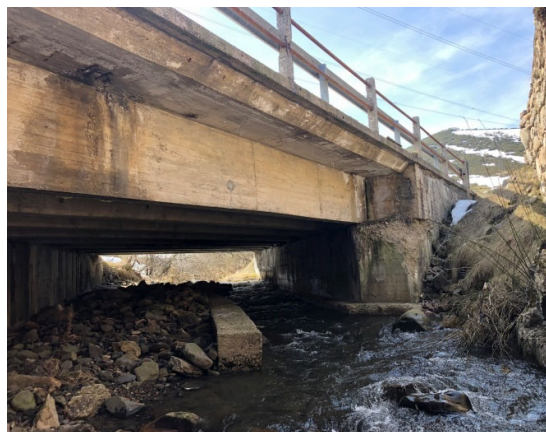
Figura 9 Vista general de la estructura
