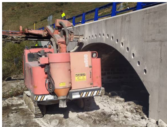
Figura 32 Cosido de bóveda en la estructura del PK 93+525
