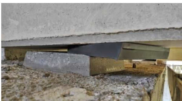
Figura 7. Apoyo parcialmente escupido.
