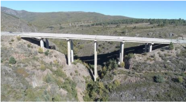
Figura 1. Vista general de los viaductos de Requejo.
