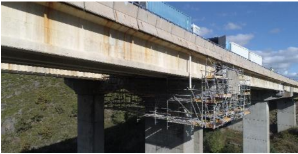
Figura 31. Andamio sobre la pila central P-3.
