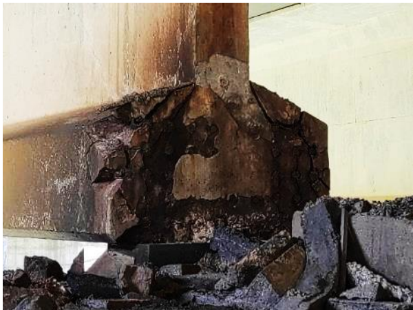
Figura 17. Culata de viga 2, vano 3 en pila P-3 (pila central, bajo junta de dilatación). Sentido Orense.
