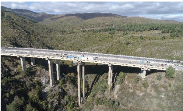
Figura 32. Vista general de los trabajos.
