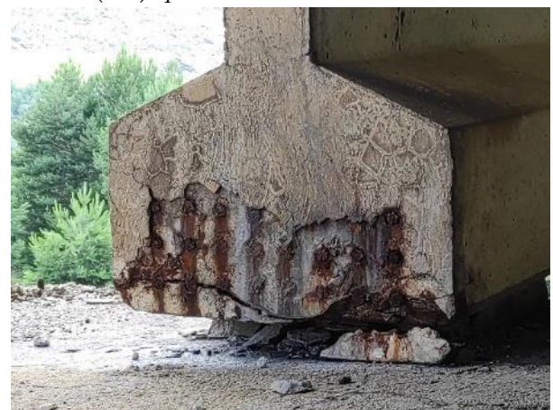
Figura 16. Culata de viga 4 (viga de borde), vano 6 en pila P-5. Sentido Benavente.
