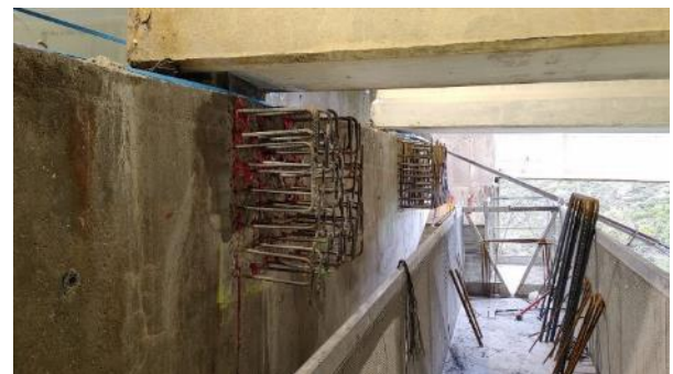
Figura 25. Ejecución de ménsulas cortas.
