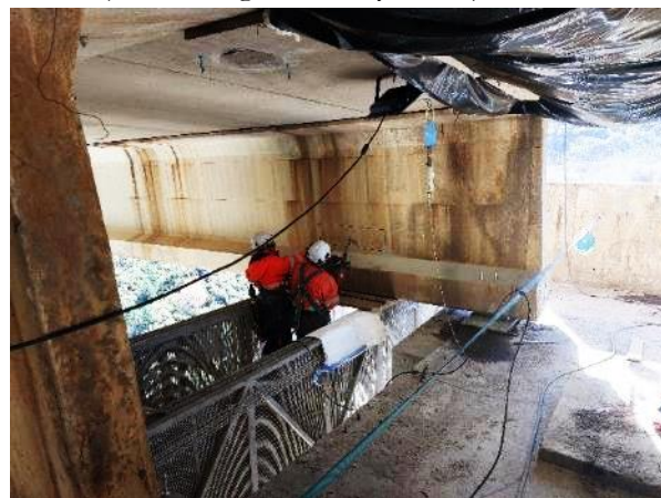
Figura 20. Ejecución de calas en alma de viga para identificación de la armadura transversal.
