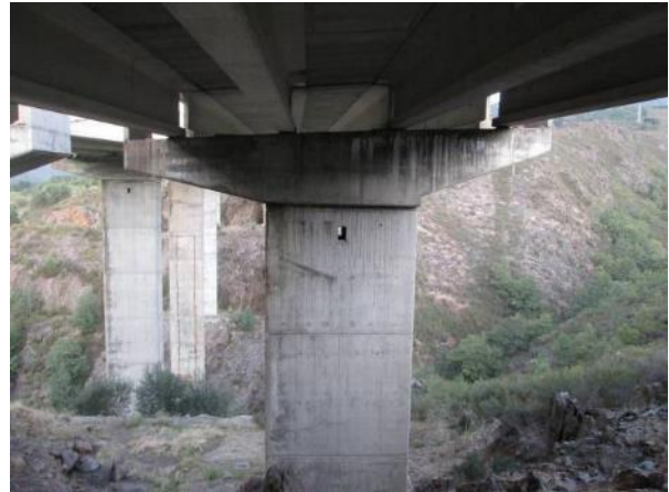
Figura 3. Vista inferior del viaducto, sentido Orense.
