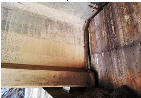
Figura 11. Situación del tablero topando en el estribo E-1 (estribo aguas abajo, Benavente).
