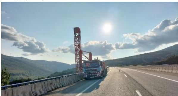
Figura 6. Camión con plataforma negativa empleado para la inspección de los aparatos de apoyo.
