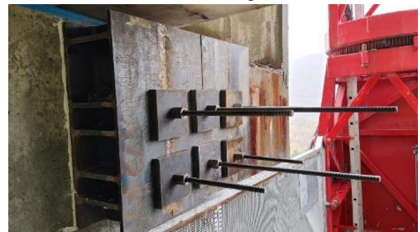
Figura 26. Refuerzo provisional de descantillado.
