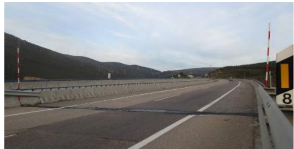
Figura 4. Plataforma desde el estribo E-2 (Orense).
