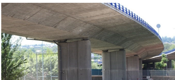
Figura 5. Vistas generales de la estructura.
