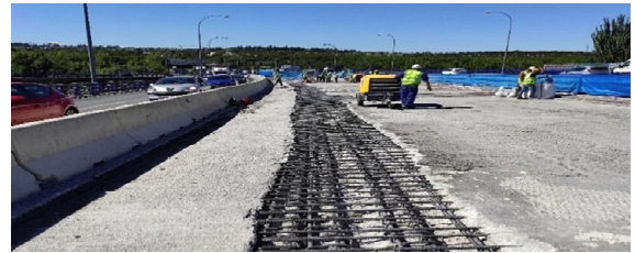
Figura 17. Vista general de un batache longitudinal de saneo del tablero
