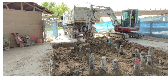
Figura 25. Excavación para ejecución del encepado tras la ejecución de los micropilotes
