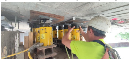
Figura 26. Operación de gateo y puesta en carga de pila de refuerzo.
