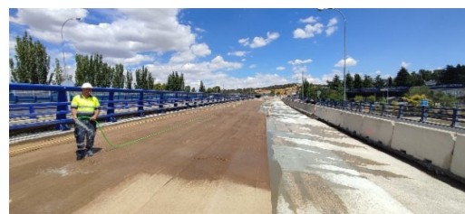
Figura 31. Operación de curado del sistema de impermeabilización
