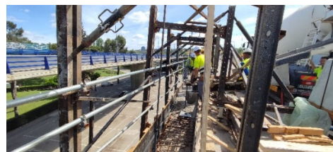
Figura 29. Hormigonado del zuncho del pretil
