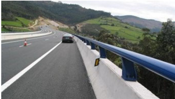
Figura 4. Pretil de hormigón in situ .
