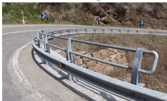
Figura 2. Barrera de seguridad metálica implantada sobre postes metálicos en estructuras.
