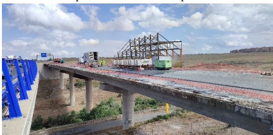
Figura 18. Hidrodemolición y carro de demolición del zócalo de cimentación del pretil.
