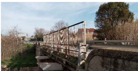
Figura 6. Pretil mixto con postes de fábrica y barandilla metálica.
