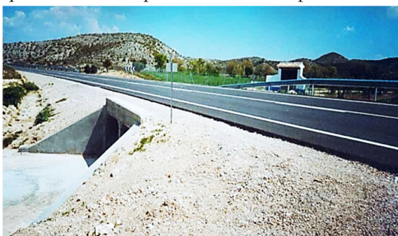
Figura 9. Obra de fábrica tipo marco sin pretil.
