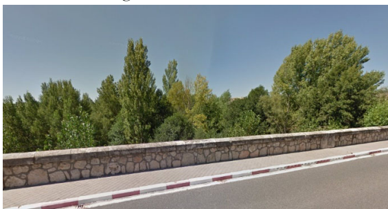
Figura 5. Pretil de fábrica.
