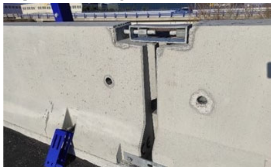
Figura 3. Pretil de hormigón prefabricado.
