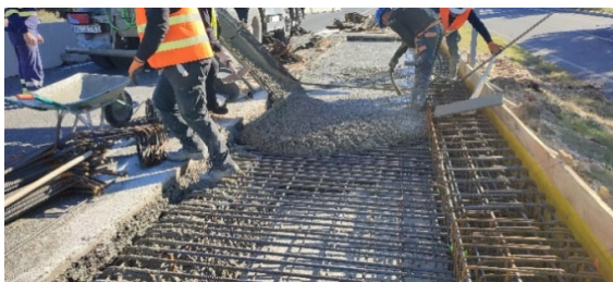
Figura 21. Hormigonado de losa de cimentación de pretil en zona de terraplén.
