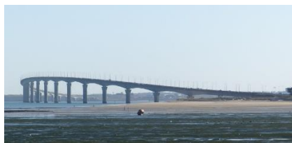
Figura 14. Vista general del puente l’île de Ré
