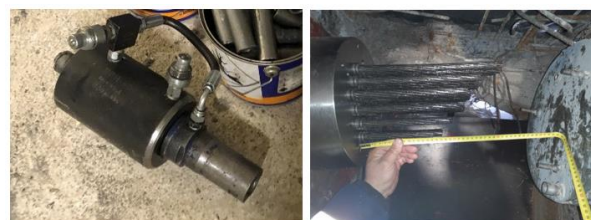
Figura 26. En la izquierda, gato mono torón de reducidas dimensiones (30 cm). A la izquierda, proceso de tesado de cables durante una operación de cambio de tendones postesados.
