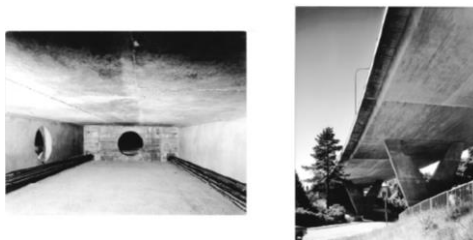
Figura 4. Braidley Road Bridge. Vista general del puente y detalle interior del sistema de pretensado [1].
