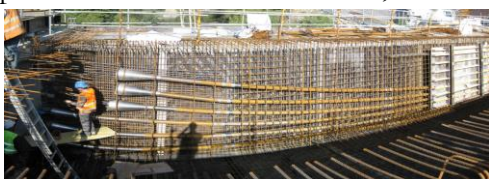
Figura 1. Detalle tipo de alma con pretensado postesado adherente.
