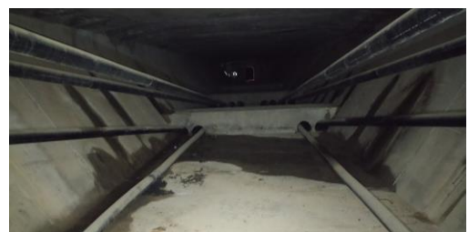
Figura 3. Vista general de puente con sección cajón y postesado interior no adherente.
