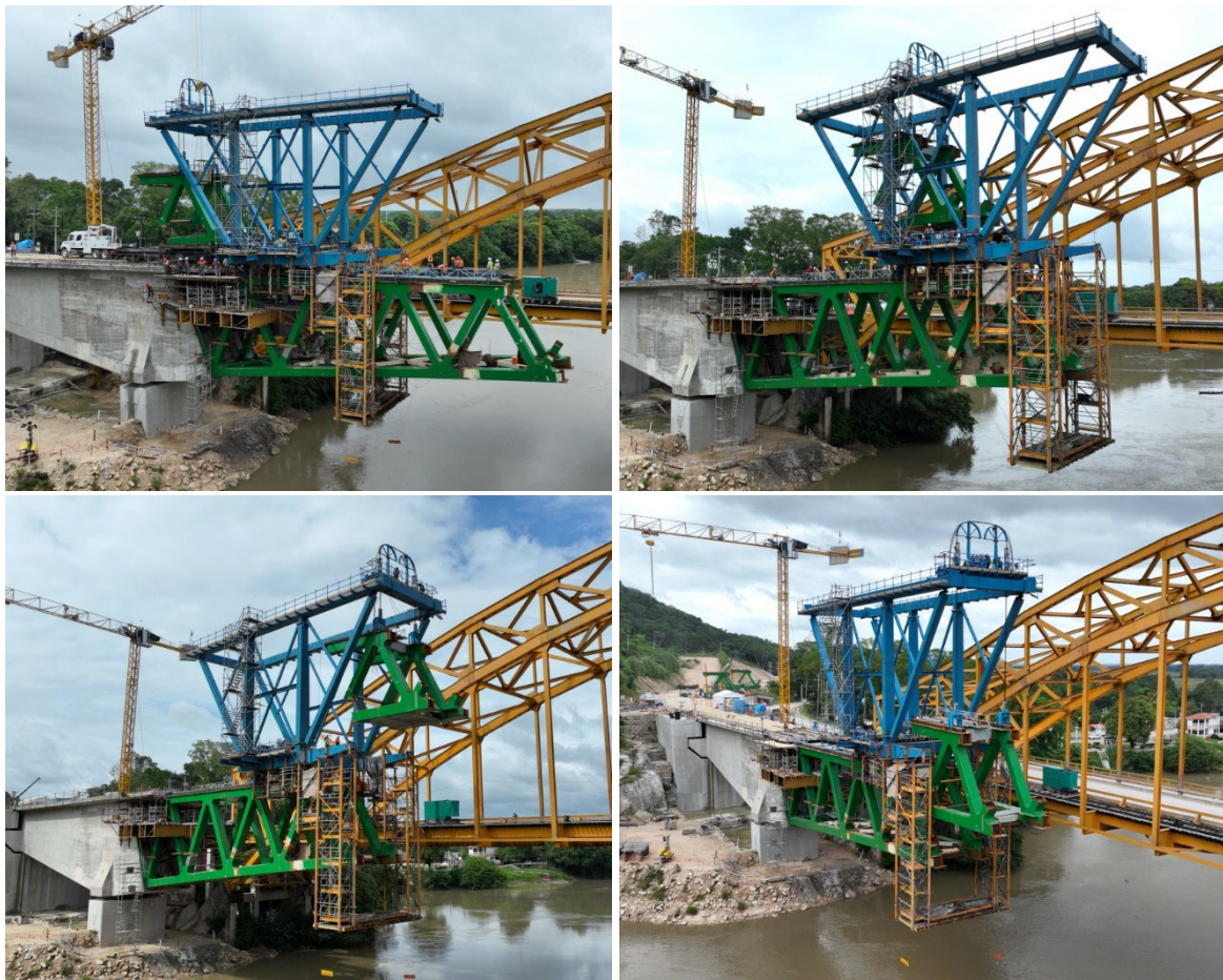
Figura 12. Ciclo tipo para la colocación de una dovela con el carro de izado móvil.
