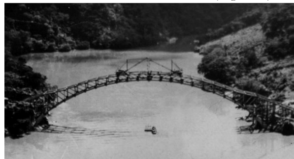
Figura 3. Cierre del arco en centro de vano.
