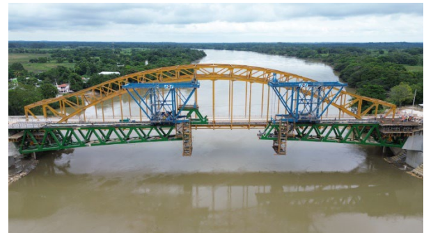
Figura 13. Vista general de los voladizos de la estructura metálica.
