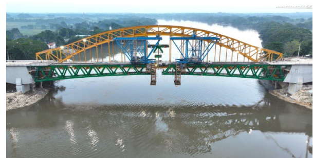
Figura 14. Cierre de la estructura metálica.
