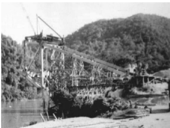
Figura 2. Empotramiento provisional de la estructura metálica.
