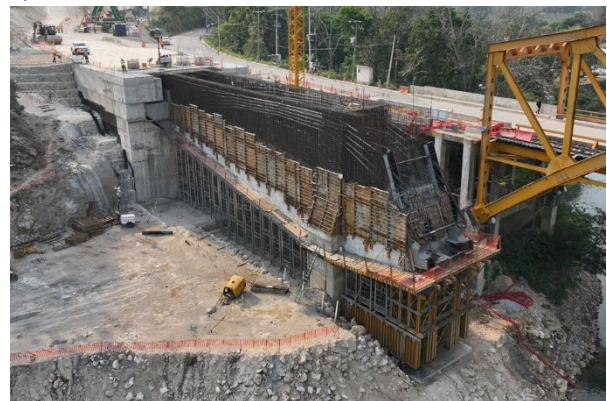
Figura 5. Ejecución de vanos de hormigón con elementos embebidos de la estructura metálica.
