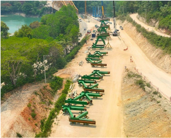
Figura 10. Unión en el parque de montaje de cada plano de la celosía en posición horizontal.
