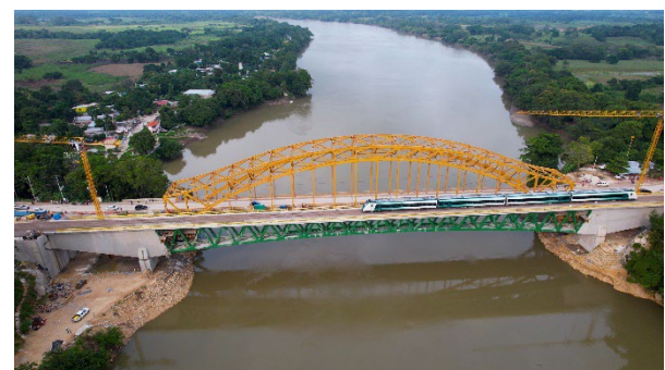
Figura 17. Puesta en servicio del nuevo puente de Boca del Cerro.
