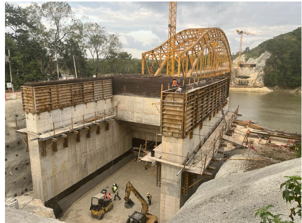
Figura 4. Ejecución de estribos.
