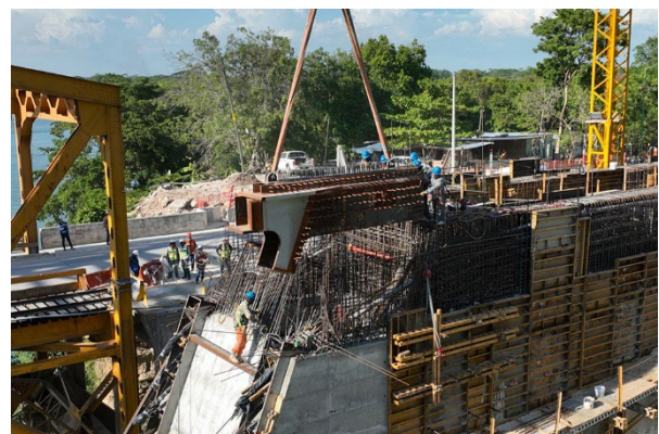
Figura 6. Colocación de elemento embebido del cordón superior.
