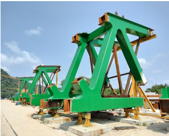
Figura 11. Ensamblado in situ de las dovelas completas.
