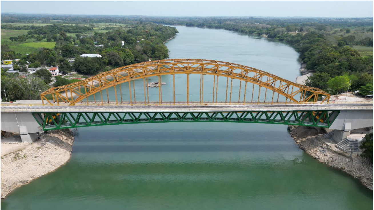
Figura 18. Vista general del nuevo puente de boca del cerro.
