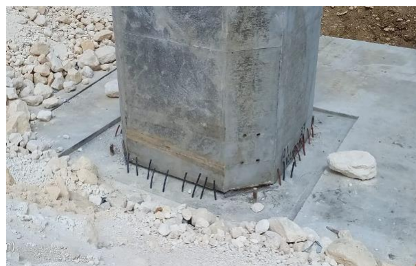
Figura 13. Fuste pendiente de inyección
