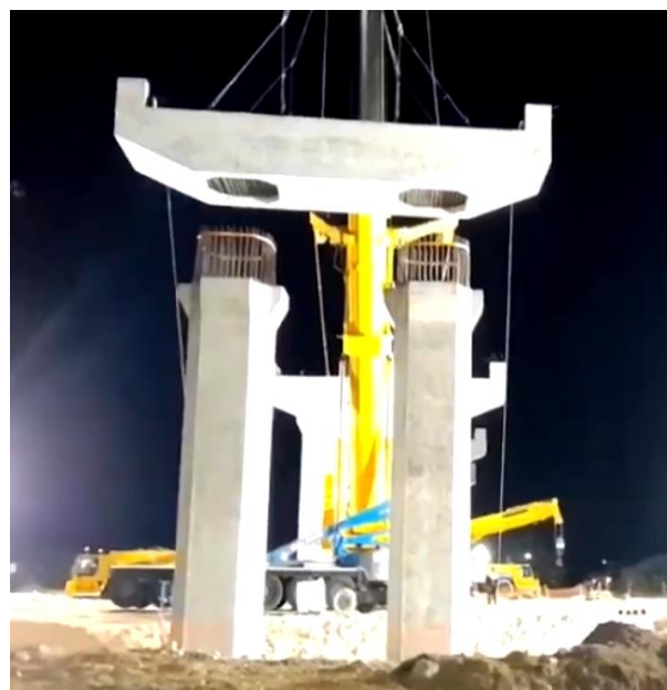
Figura 17. Instalación del capitel
