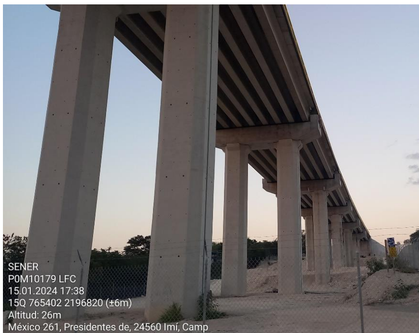
Figura 4. Vista general del viaducto Uman
