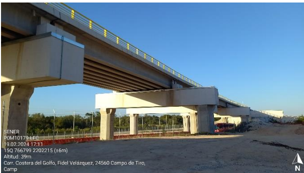
Figura 21. Pórtico del Viaducto 4044.1 al finalizar las obras
