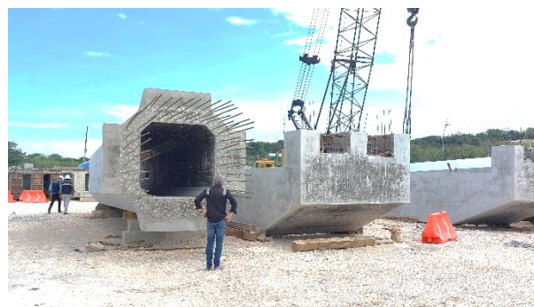
Figura 16. Espera superior en fuste y capitel
