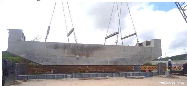
Figura 15. Capitel en parque de prefabricación
