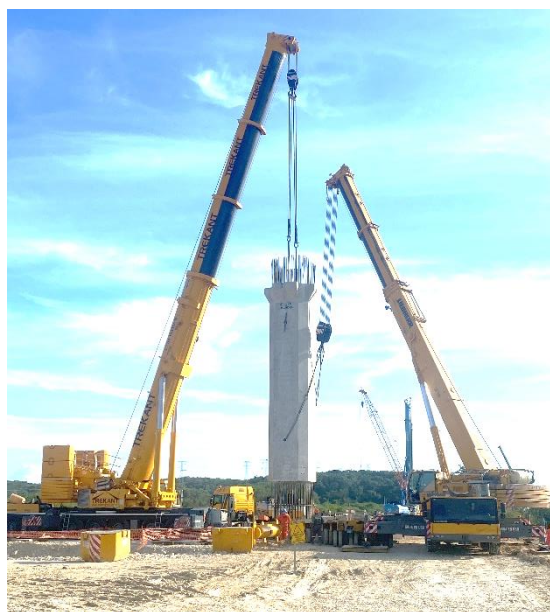
Figura 11. Posición final de izaje
