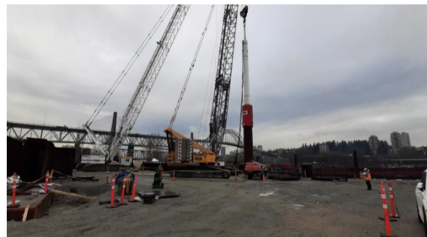
Figura 6. Rehinca del pilote con el martillo S-800.
