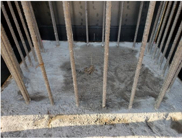
Figura 9. Armadura de conexión pila-pilote colocada a posteriori del hormigonado del pilote.
