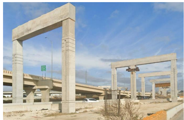
Figura 12. Vista de varias pilas pórtico consecutivas con 2 y 3 fustes.
