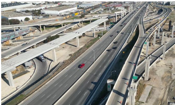
Figura 3. Vista general del enlace entre I35 y N410 durante su construcción.
