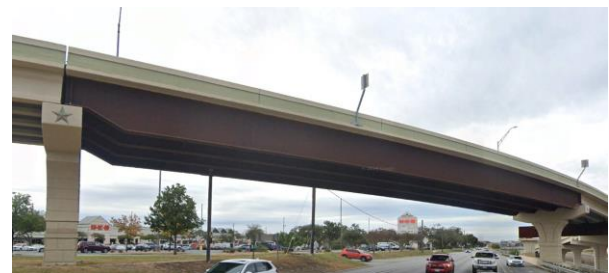
Figura 5. Vista de un vano metálico.
