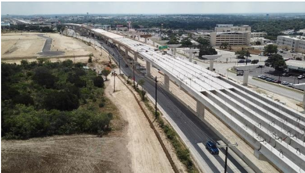
Figura 4. Vista general de la superestructura de un tramo tipo de viaducto durante la construcción.
