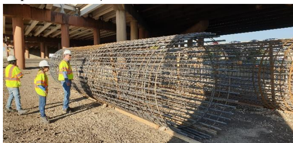
Figura 6. Armadura de pilote de 8' de diámetro.
