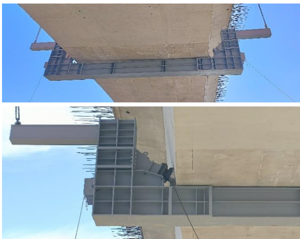
Figura 11. Prueba de carga en nichos de puntales
