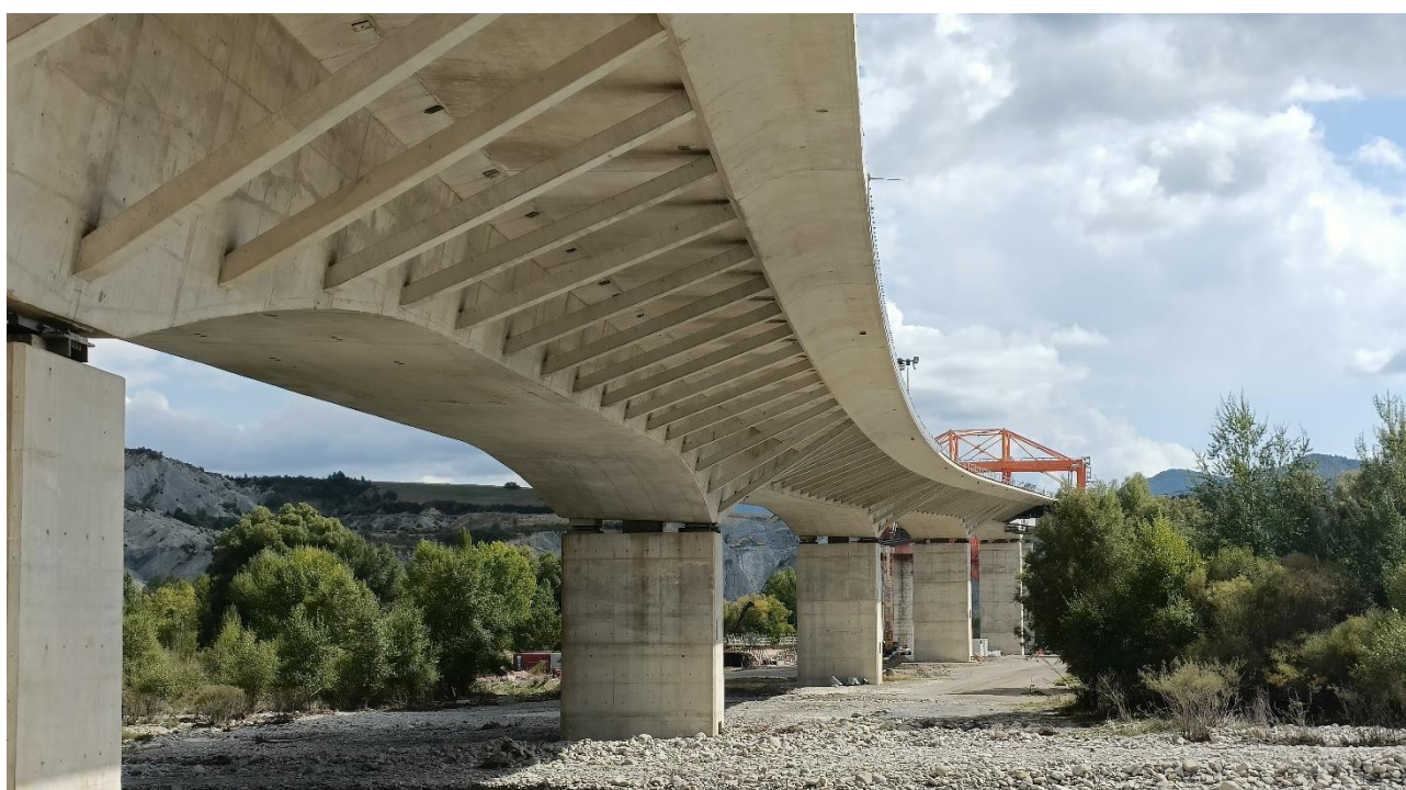
Figura 1. Visión inferior del viaducto con una vista en escorzo desde la pila P2
