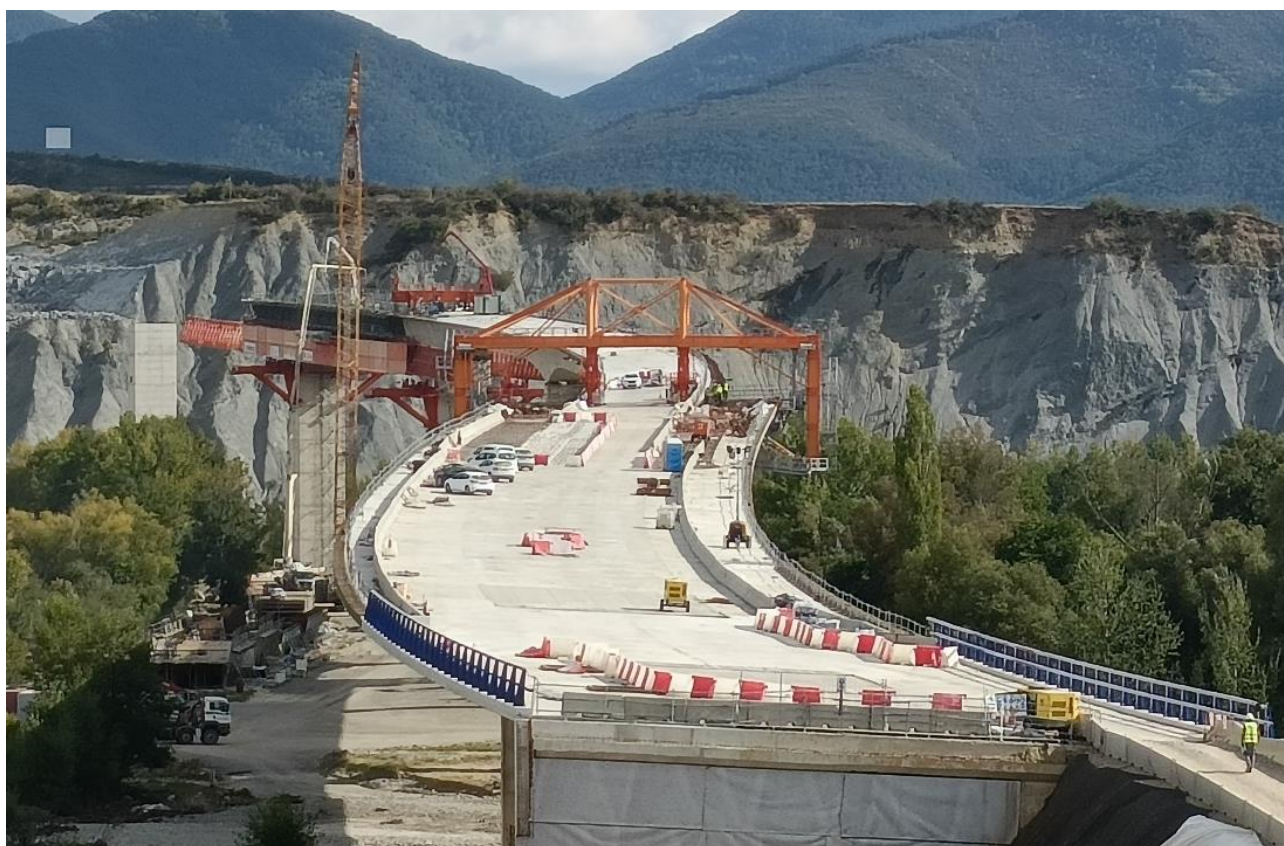
Figura 9. Vista aérea de la estructura en ejecución desde el E-2
