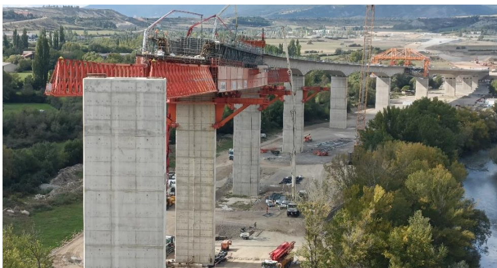
Figura 8. Vista del viaducto en ejecución desde el Estribo 1. En primer plano destaca la autocimbra. Al fondo el carro de alas
