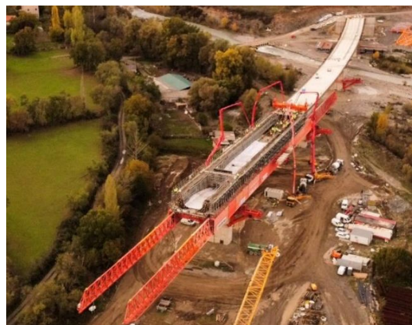
Figura 7. Imagen aérea del hormigonado de la sección parcial en U
