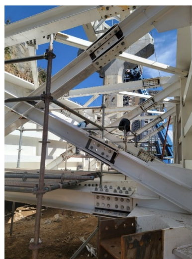
Figura 5. Uniones atornilladas en celosías transversales para unión en obra.
