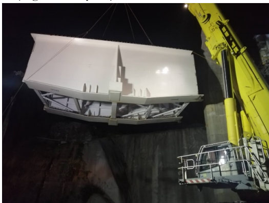
Figura 15. Izado de dovela sobre pila P4 (Fase 2).
