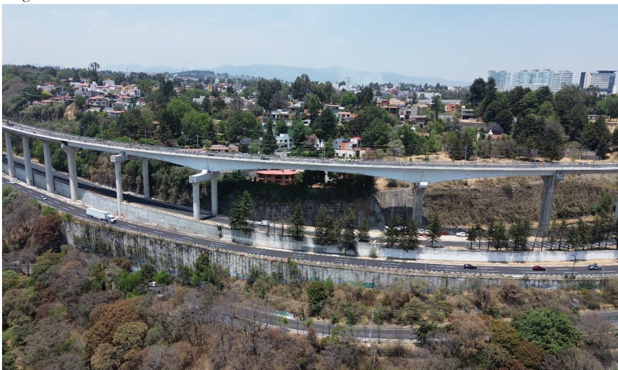
Figura 2. Vista general del Viaducto 3 de la línea México-Toluca
