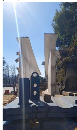
Figura 4. Jácenas transportadas individualmente a obra.
