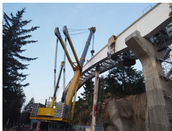
Figura 18. Finalización de la operación de izado de vigas metálicas (Fase 5).
