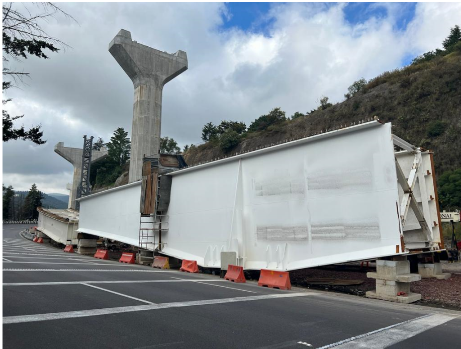
Figura 11. Dovelas montadas y preparadas para el izado.
