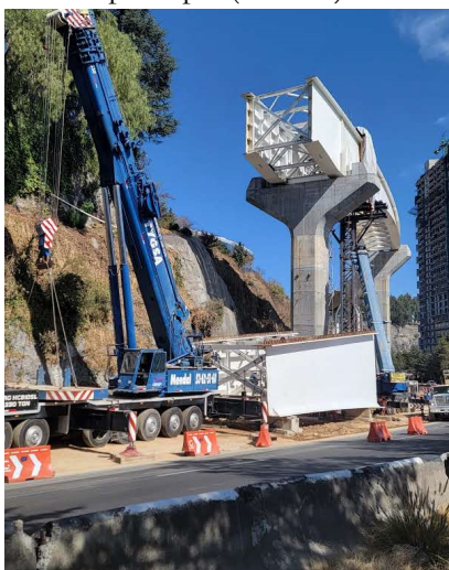
Figura 16. Montaje dovela de voladizo del vano principal (Fase 4).
