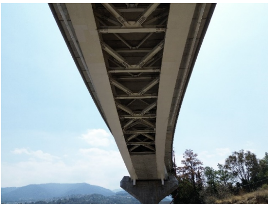
Figura 8. Vista inferior. Celosía en K.
