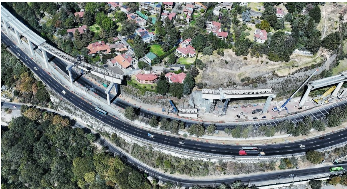
Figura 19. Vista aérea del montaje con grúas de la viga metálica (tras la fase 3 de montaje).
