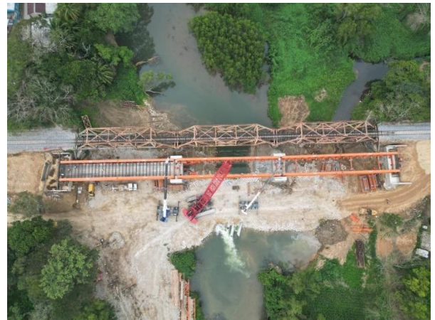
Figura 13. Vista Aérea Tolosita en construcción
