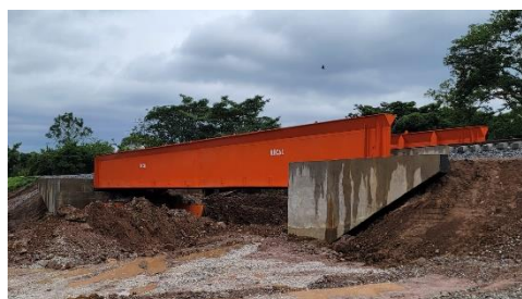
Figura 36. Puente acabado a falta de montaje de protección socavación.
