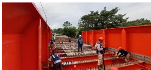
Figura 32. Montaje de prelosas
