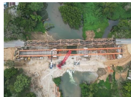
Figura 30. Montaje con grúas Tolosita
