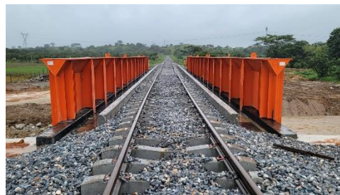
Figura 35. Montaje de vías
