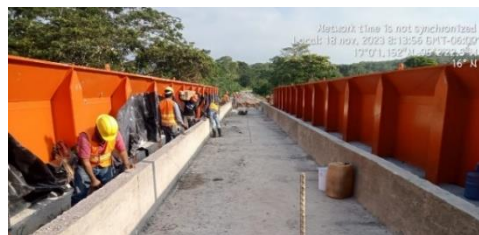
Figura 34. Colado muretes guardabalasto
