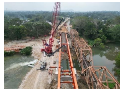
Figura 29. Montaje con grúas Tolosita
