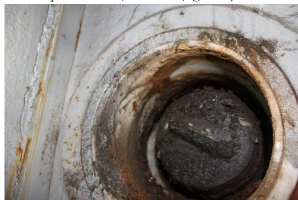
Figura 6. Cerrojo de aguas abajo
