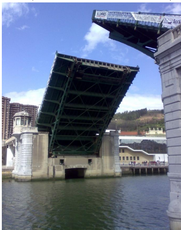
Figura 2. Vista del tramo móvil del puente de Deusto durante su apertura (marzo 2008)
