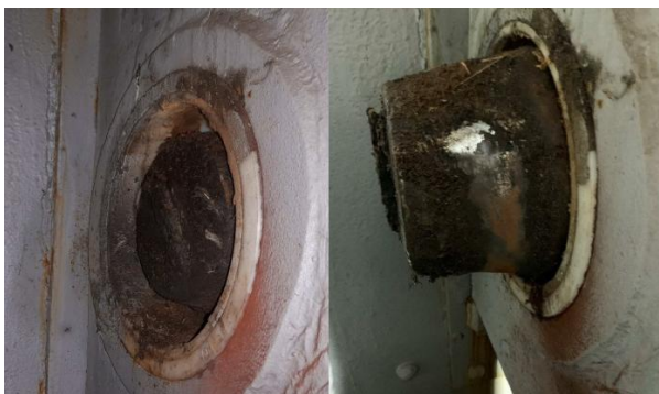
Figura 13. Posición del bulón aguas abajo antes y después de la actuación.
