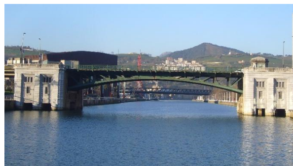
Figura 1. Vista general del tramo móvil del puente de Deusto
