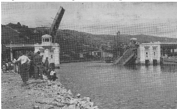
Figura 5. Fotografía del tramo móvil tras la voladura de la hoja del lado Bilbao
