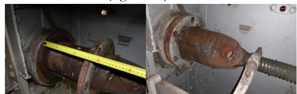
Figura 11. Anillo de guía antes y después de su reposición.
