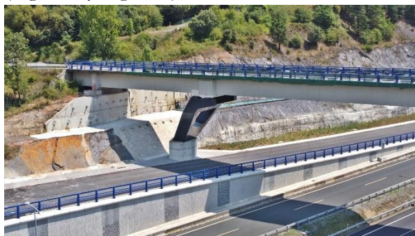
Figura 4. Vista lateral de la pila
