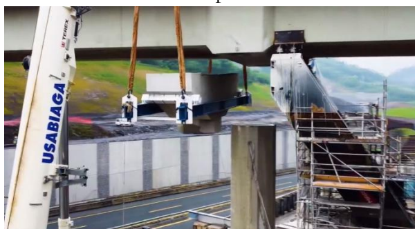
Figura 14. Retirada del dintel de la pila original
