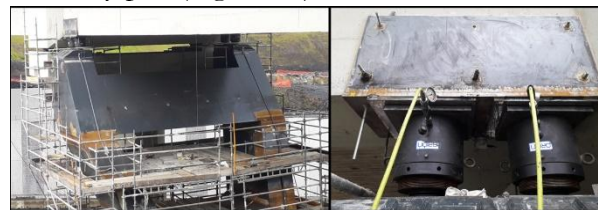
Figura 13. Dovela 4 con gatos de Fase 1 instalados
