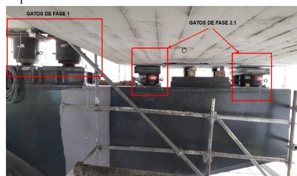
Figura 15. Ubicación de gatos para la Fase de Transferencia 2.1
