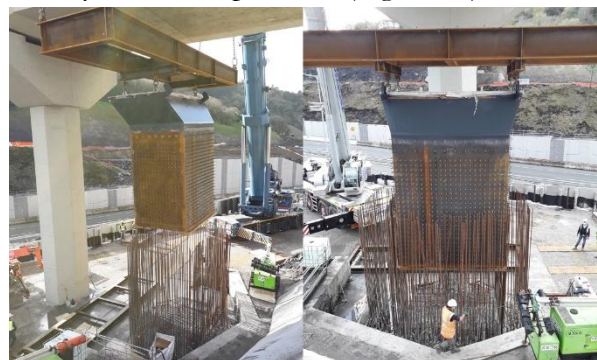
Figura 11. Montaje de dovela 1
