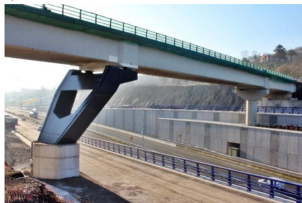
Figura 5. trasera de la estructura
