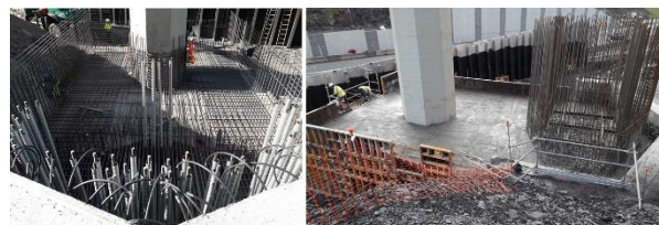
Figura 10. Trabajos de armado y hormigonado de la zapata
