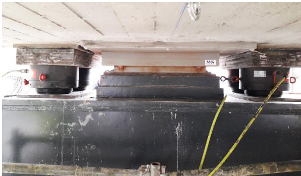
Figura 16. Gatos y aparato de apoyo para la Fase de transferencia 2.2
