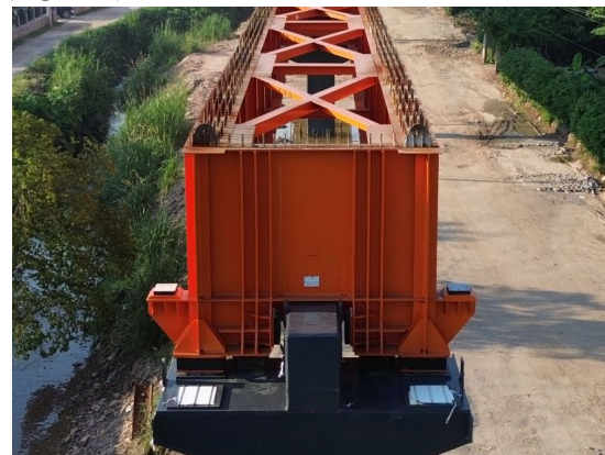
Figura 5. Mamparo de apoyo del tablero.
