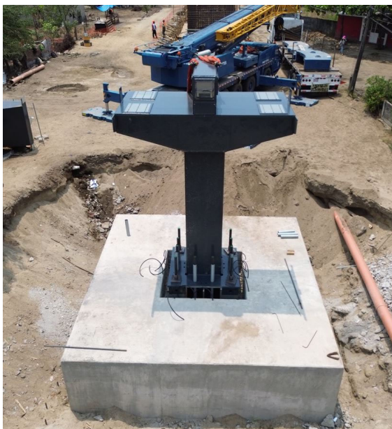
Figura 7. Alzado e imagen de pila metálica tipo durante su ejecución.
