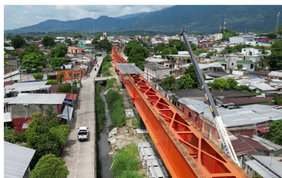
Figura 2. Vista general del viaducto en fase constructiva.
