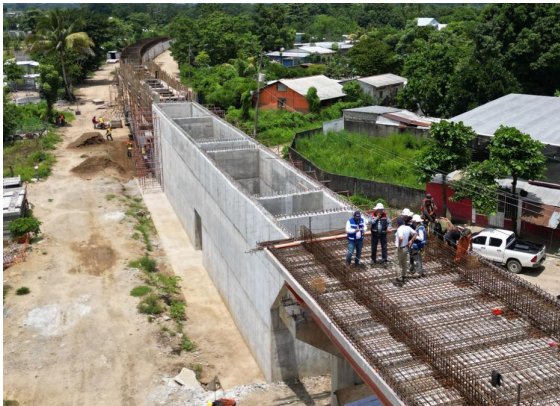
Figura 9. Imagen del cajón durante la ejecución del tramo de unión entre rampa y tablero.
