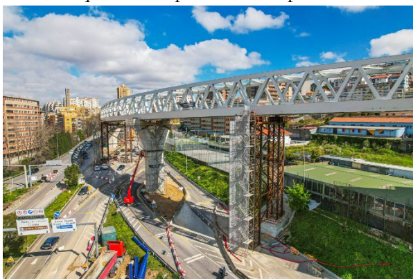
Figura 11 Detalle de pilas provisionales sobre carretera inferior.
