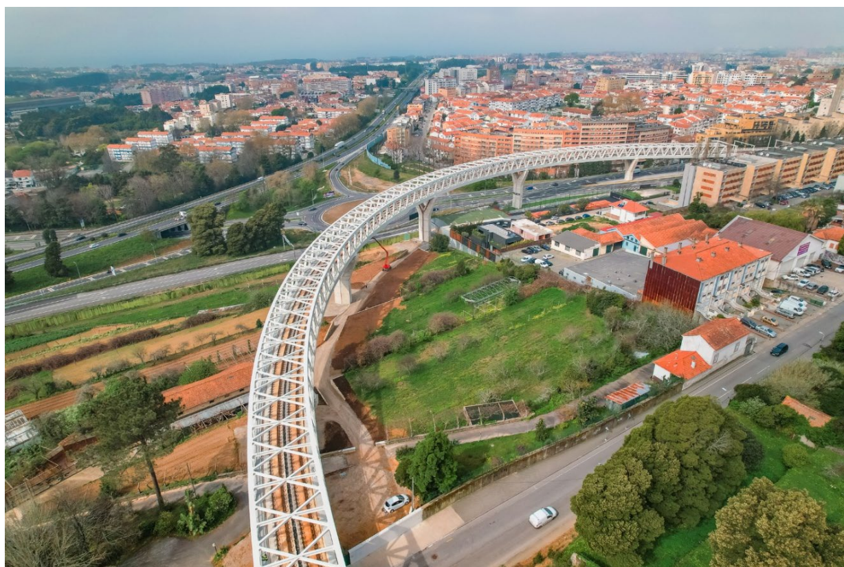
Figura 4: Vista general del Viaducto
