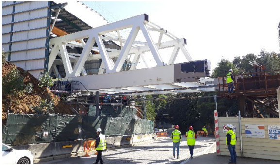
Figura 6 Detalle de fases iniciales de maniobra de empuje.
