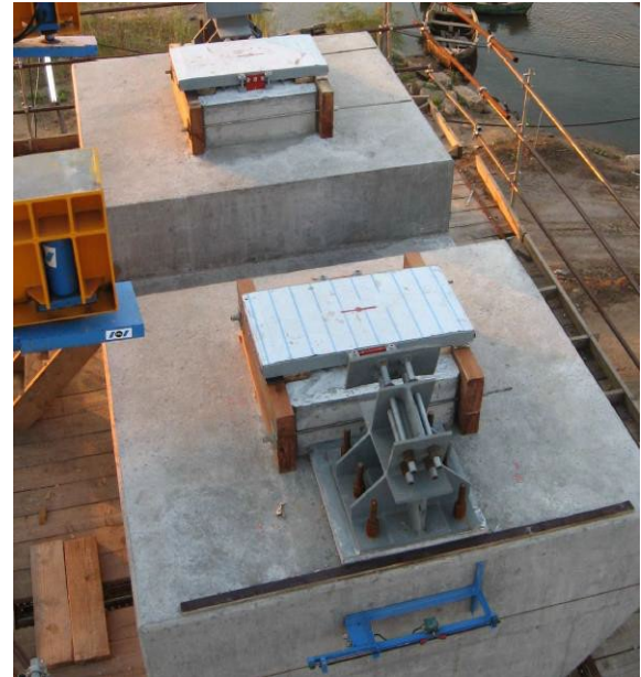
Figura 8 Detalle de apoyos tipo Dual Function.
