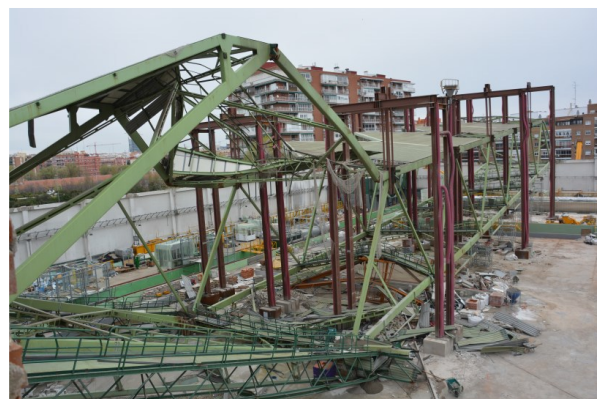
Figura 8. Vistas de las celosías principales antes de su desmontaje.
