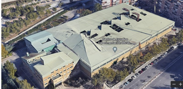
Figura 1. Restitución fotogramétrica del Centro de Estudios de Puertos y Costas del CEDEX tras el colapso (fuente: Google Earth).
