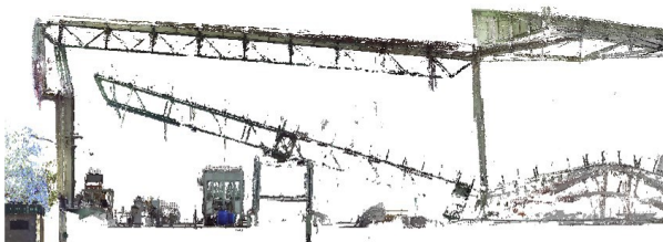
Figura 12. Detalle de un par de cubierta hundido y pérdida de apoyo de la pasarela .
