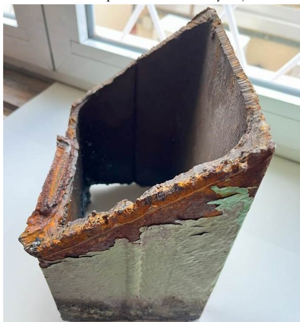
Figura 20. Extremo de diagonal en R14.
