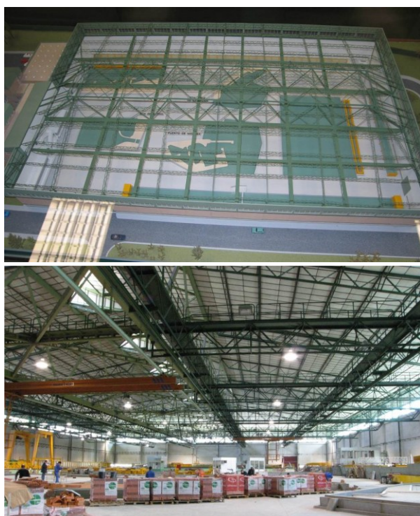
Figura 3. Vista de una maqueta de la cubierta y de su interior antes del colapso.
