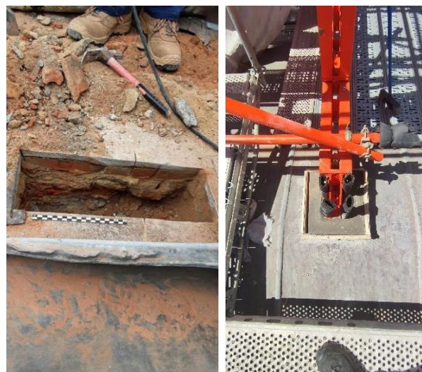
Figura 6: Cala realizada en cubierta para ver la configuración de la bóveda y apoyo de andamio ya finalizado.
