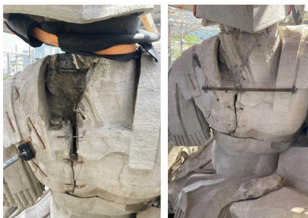
Figura 10: Ejemplo de reparación en el frontal de la panoplia recostada derecha. En la parte izquierda se muestra el frontal antes de la restauración y en la derecha la escultura con la nueva grapa y la reparación de la piedra realizada.
