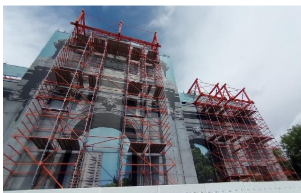
Figura 5: Ejemplo de cimbra de sustentación de panoplia y fotografía del andamio.
