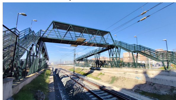
Figura 1. Vista general de la pasarela
