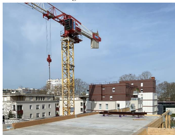
Figura 6. Forjados mixtos madera y hormigón.
