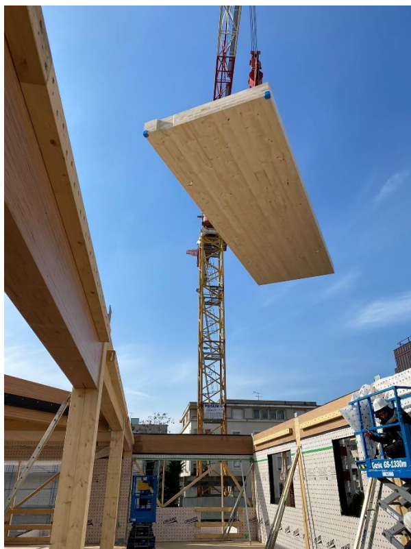
Figura 5. Montaje de los forjados de madera contralaminada.
