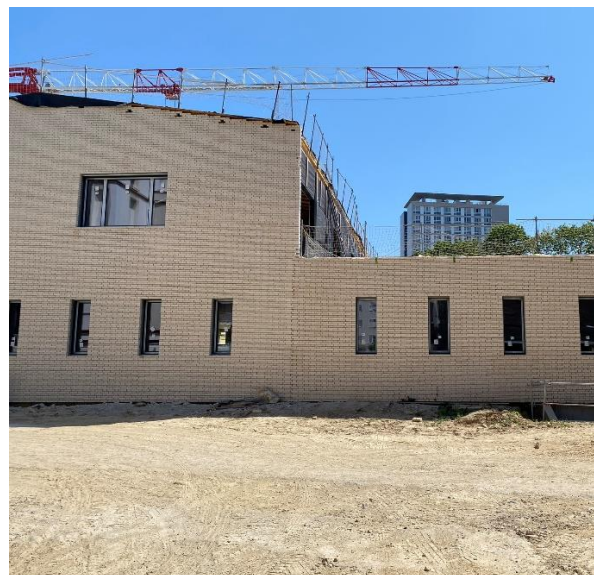
Figura 11. Revestimiento de ladrillos de la fachada.
