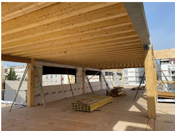
Figura 7. Forjados mixtos madera hormigón.
