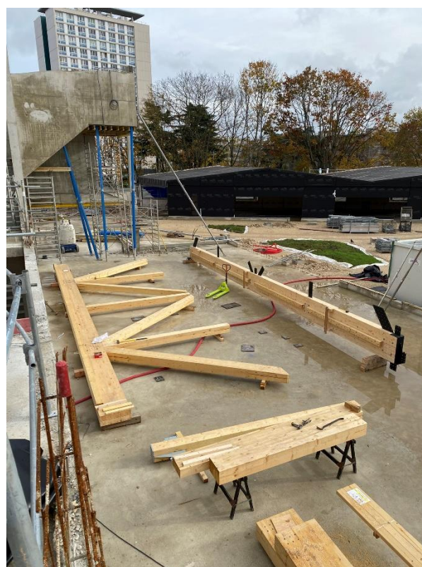
Figura 9. Montaje de la viga en celosía prefabricada en taller.
