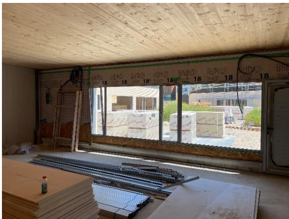
Figura 14. Ventanales. La viga del dintel es integrada al muro de madera.
