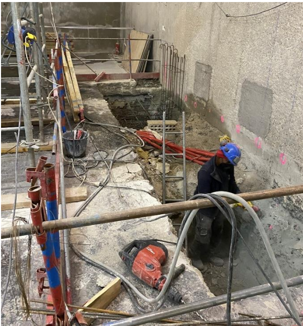
Figura 16. Zapatas de cada lado de la zapata del pilar P12.
