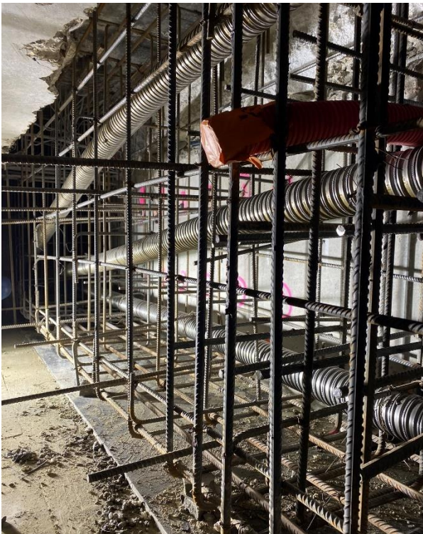
Figura 20. Vainas para los cables de pretensado.
