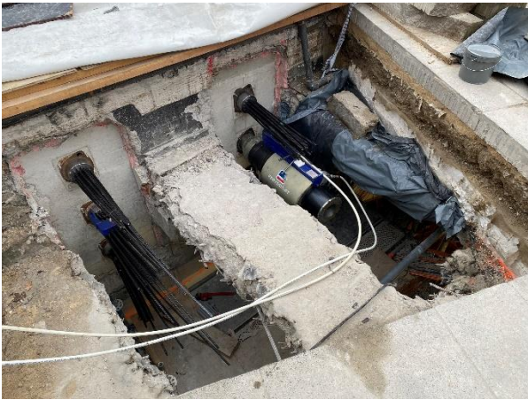
Figura 23. Gato hidráulico de postensado.
