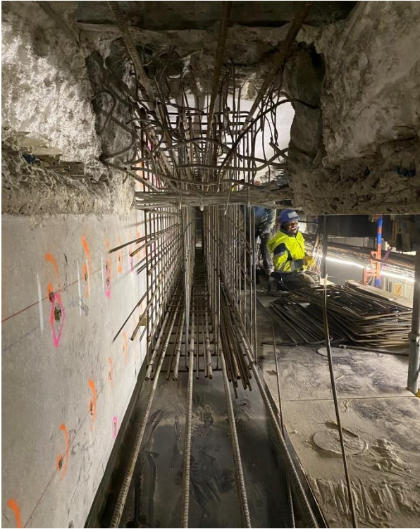
Figura 19. Colocación de las armaduras desde la plataforma de trabajo.
