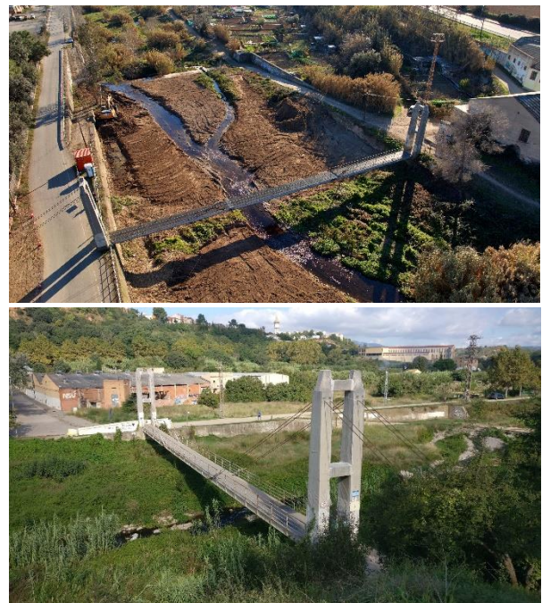
Figura 4. Vista de las pasarelas al inicio de las obras.
