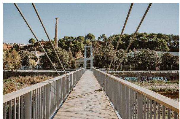
Figura 21. Acabados de las pasarelas.
