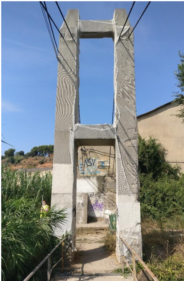
Figura 8. Vista de la pila en el estado inicial.
