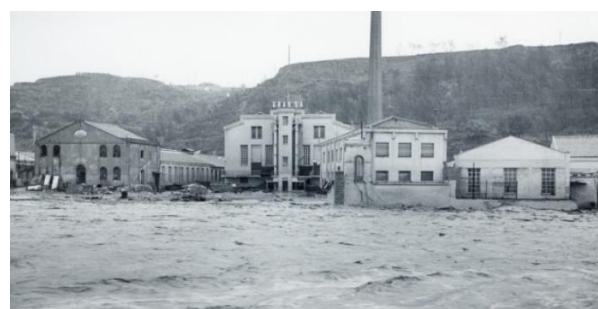
Figura 2. Imagen de la Fábrica de Grau, S.A. inundada después de la avenida de 1962.
