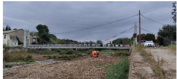
Figura 20. Prueba de carga estática en Can Grau.
