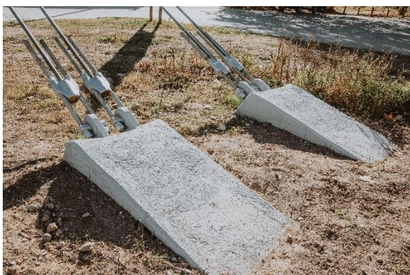
Figura 14. Anclaje del tirante en el muerto.
