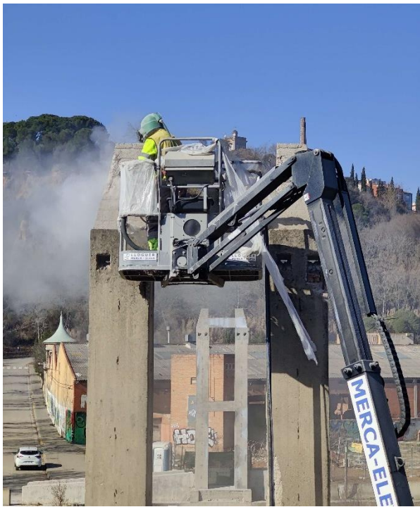
Figura 17. Vista la rehabilitación de las pilas.
