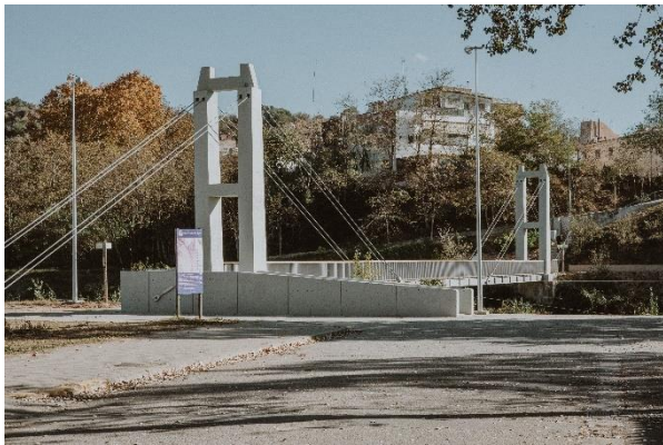
Figura 22. Vista de las pasarelas terminadas.
