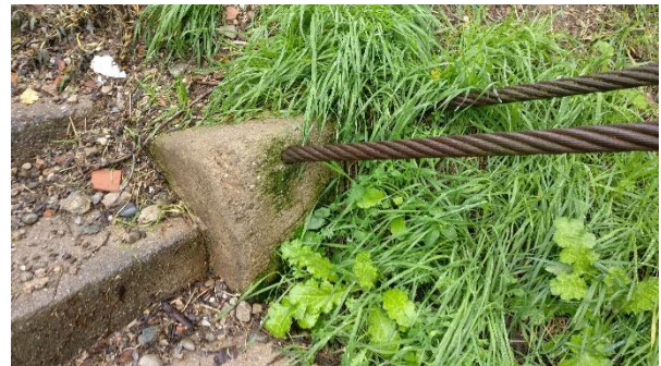
Figura 9. Detalle del anclaje en el terreno.
