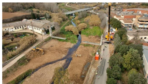
Figura 16. Vista del desmontaje de la pasarela de Can Grau.
