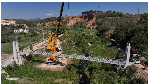
Figura 18. Montaje de la pasarela del Molí d'en Fontanet.
