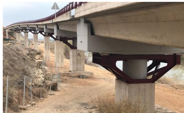
Figura 22. Refuerzo de pilas y dinteles del viaducto sobre el ffcv en Quinto.
