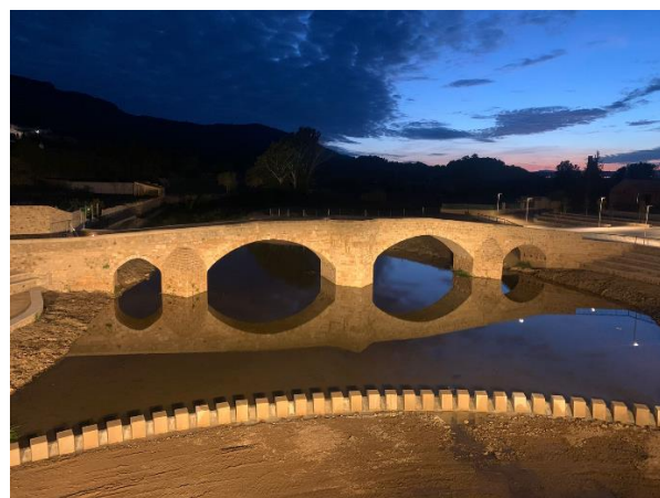
Figura 13. Vista después de la restauración.
