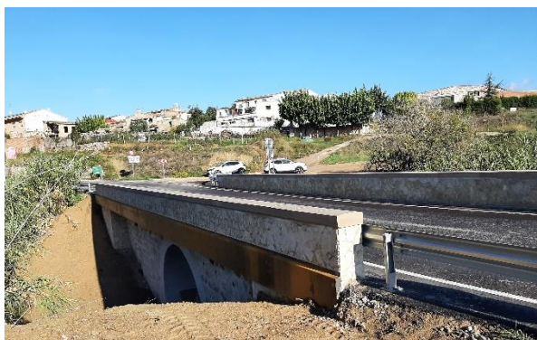
Figura 21. Ampliación del puente de can Cartró en Subirats. La barrera es de muros que recuperaban el aspecto inicial de los pretils de mampostería.
