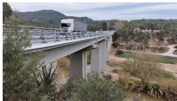
Figura 11. Puente de la C58 en Monistrol restaurado.
