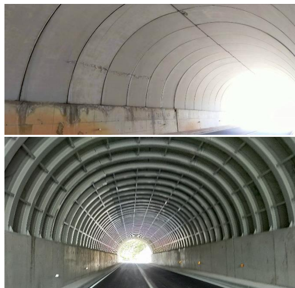
Figura 1. Vista del falso túnel durante la inspección visual (sup.) y con la obra de refuerzo acabada (inf.).
