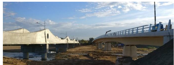
Figura 26. Puentes ferroviario y viario sobre la Tordera después de su reconstrucción.
