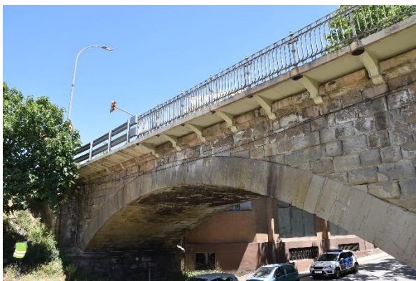
Figura 19. Estado actual del puente de Sant Francesc en Manresa
