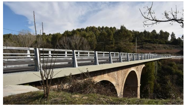
Figura 16. Ampliación del puente de Fonollosa para disponer barreras de seguridad homologadas. Se utilizó una prelosa prefabricada que permitía mantener un carril de circulación con cortes intermitentes.
