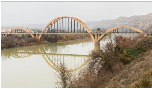
Figura 14. Puente de Sástago antes de la reparación
