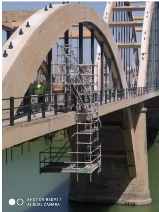
Figura 15. Puente de Sástago en el proceso de refuerzo de los tirantes.
