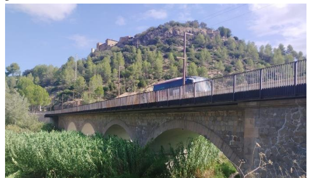
Figura 17. Ampliación del puente de Castellbell i el Vilar para añadir una acera peatonal. Desvío del tráfico y corte completo.
