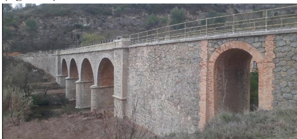
Figura 9. Puente de la Boixera ya restaurado.
