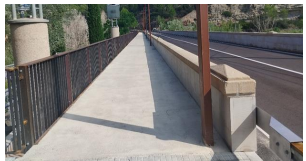
Figura 18. Ampliación del puente de Castellbell i el Vilar para añadir una acera peatonal. Pretiles recuperados del puente original
