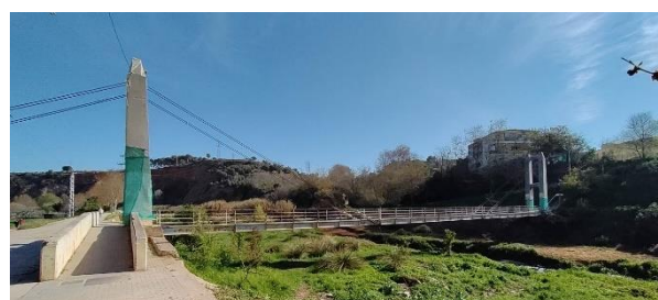
Figura 6. Pasarela sobre el río Ripoll en Sabadell.
